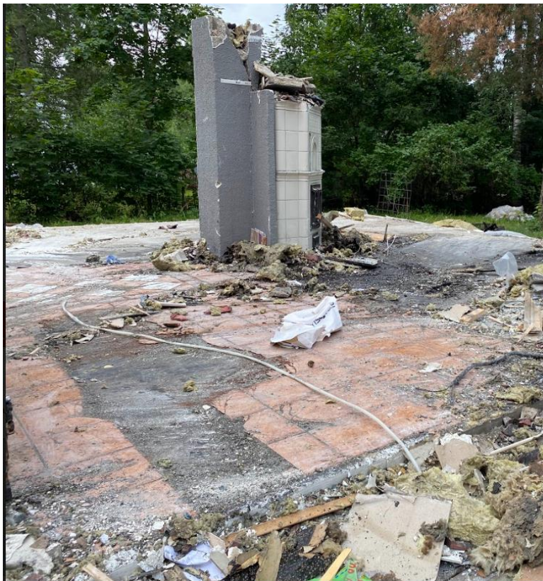
Kuva 7. Purkaminen käynnissä (Kuva Tuukka Invenius 2022)
