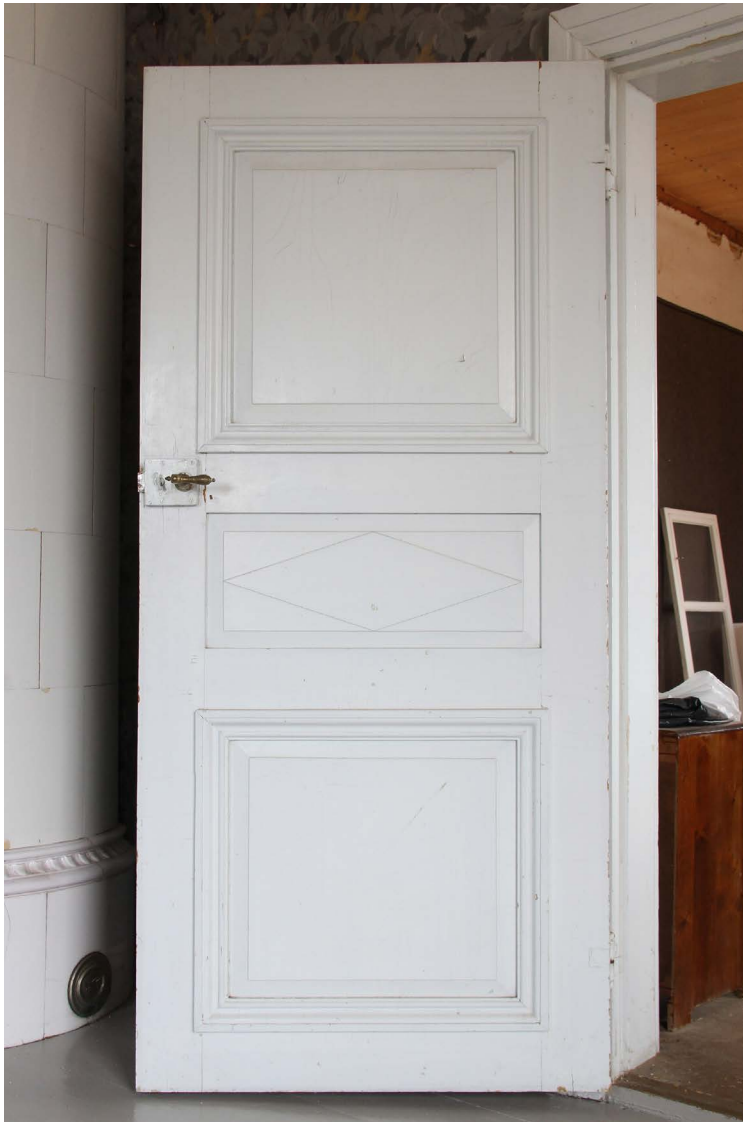
Kuva 13. Sisäövet. Ovet ovat kolmipeilisiä ja niistä ylin on kooltaan suurin. Osassa ovista on keskipeilissä vinoneliö koristeena. Kuva: Ville-Matti Rautjoki.
