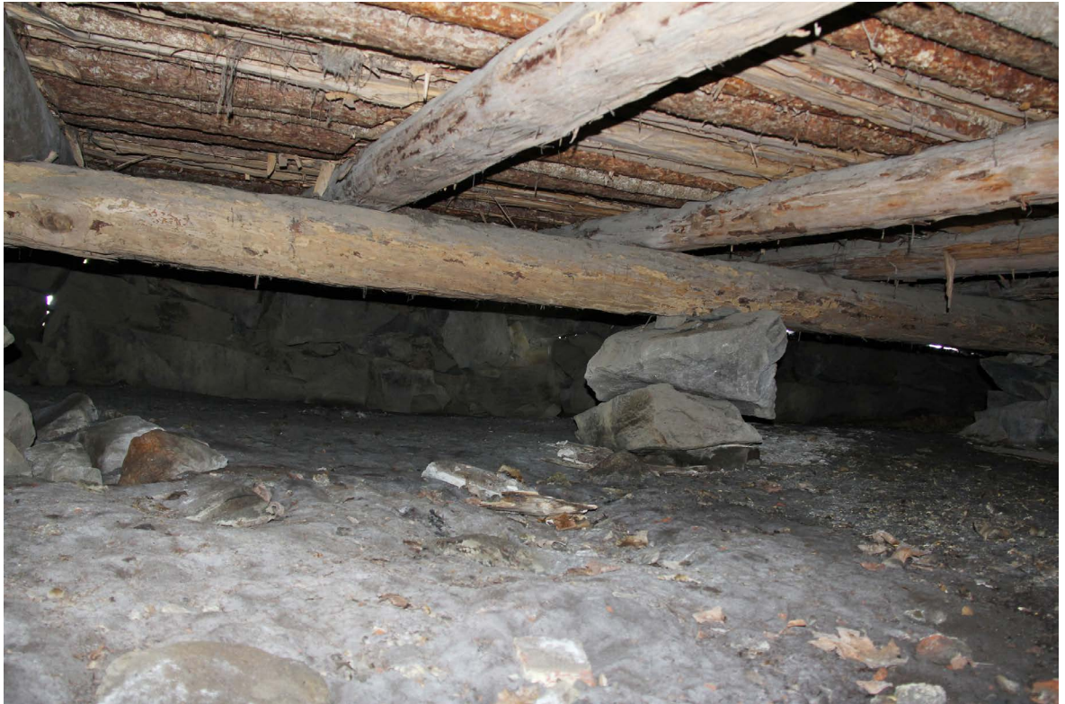
Kuva 6. Alapohjan tukirakenteita. Ryömintätilan korkeus on noin 60-70 cm maanpinnasta. Kuva: Ville-Matti Rautjoki.
