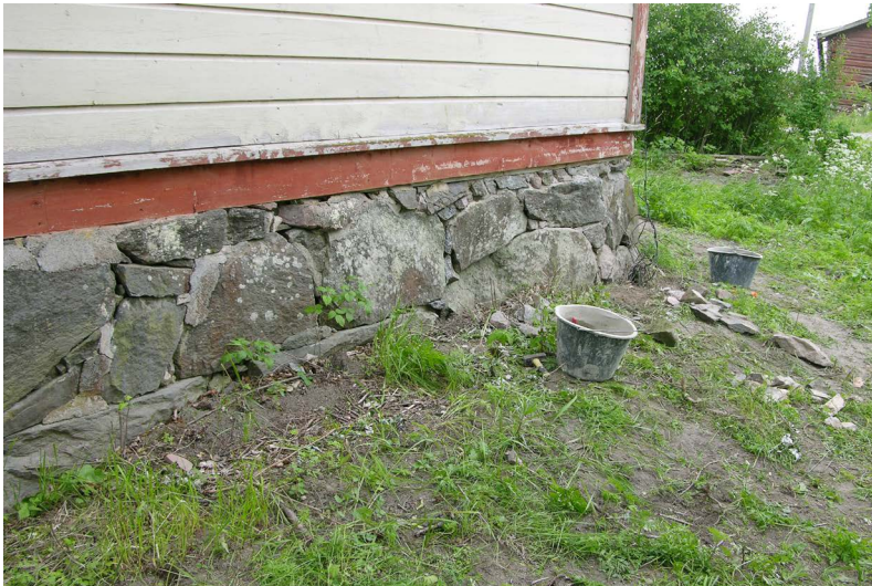
Kuva 4. Vanhan osan kivijalkaa. Kuva: Ville-Matti Rautjoki.
