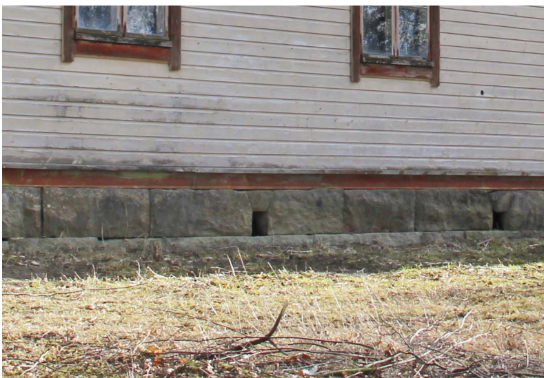
Kuva 5. Uuden osan säännöllistä kivijalkaa. Kuva: Ville-Matti Rautjoki.
