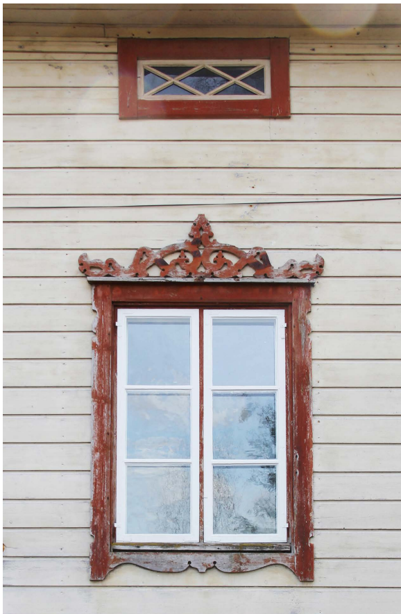
Kuvat 11 ja 12. Vasemmalla kuvassa 11 näkyvä vanhan osan alaikkunan nikkarityylinen koristelu on samankaltainen kuin Loimaan rautatieaseman julkisivuissa. Myös haukkaikkunoiden malli viittaa samaan rakennukseen. Kuvassa 12 näkyvät 1907 laajennusosan T-malliset ikkunat ja yksinkertaisempi haukkaikkunamalli. Kuvat: Ville-Matti Rautjoki
