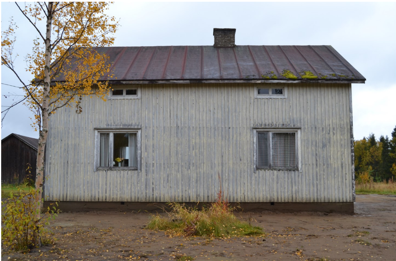
KUVA 3. Yleiskuva kohteesta (Heikkinen 2022)
