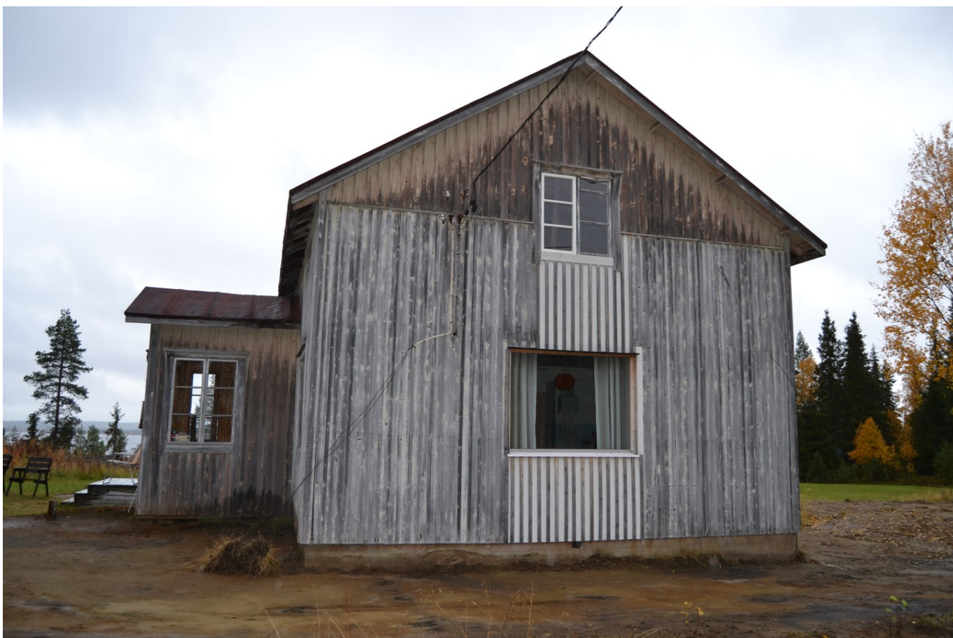
KUVA 2. Yleiskuva kohteesta (Heikkinen 2022)
