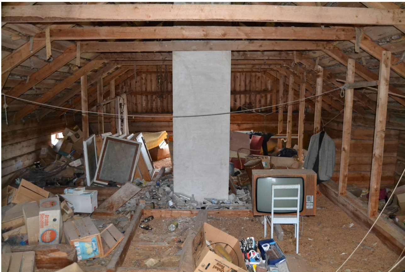
KUVA 40. Ullakkoa ja yläpohjarakenteita sekä keskushormi (Heikkinen 2022)
