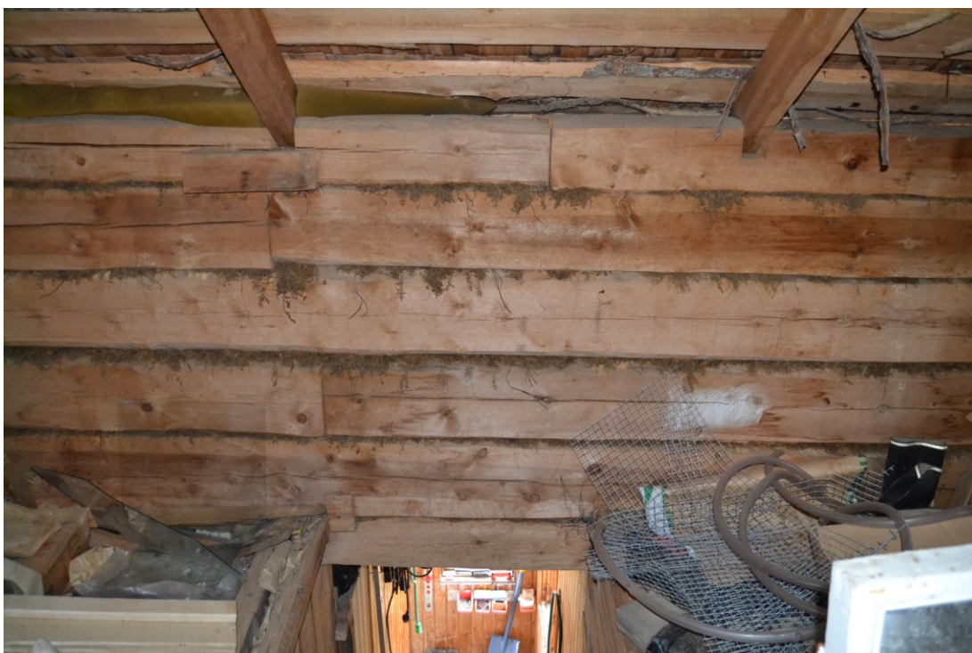
KUVA 20. Yläpohjassa näkyvissä hyvin hirsirunkorakenne ja aikanaan hirsien väliin tilkkeeksi laitettut sammalet (Heikkinen 2022).
