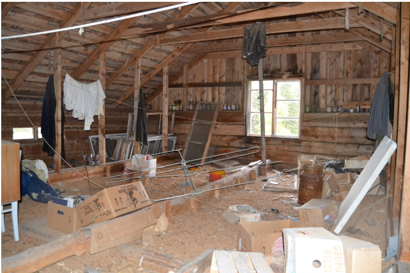
KUVA 39. Ullakko ja yläpohjarakenteet (Heikkinen 2022)
