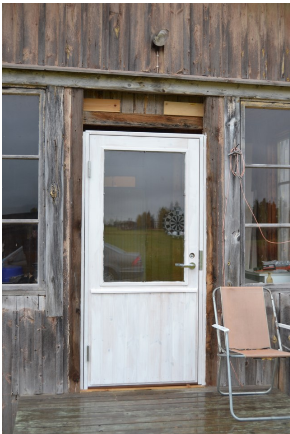
KUVA 27. Uusittu ulko-ovi. Yläpuolelle tulossa ikkuna (Heikkinen 2022)
