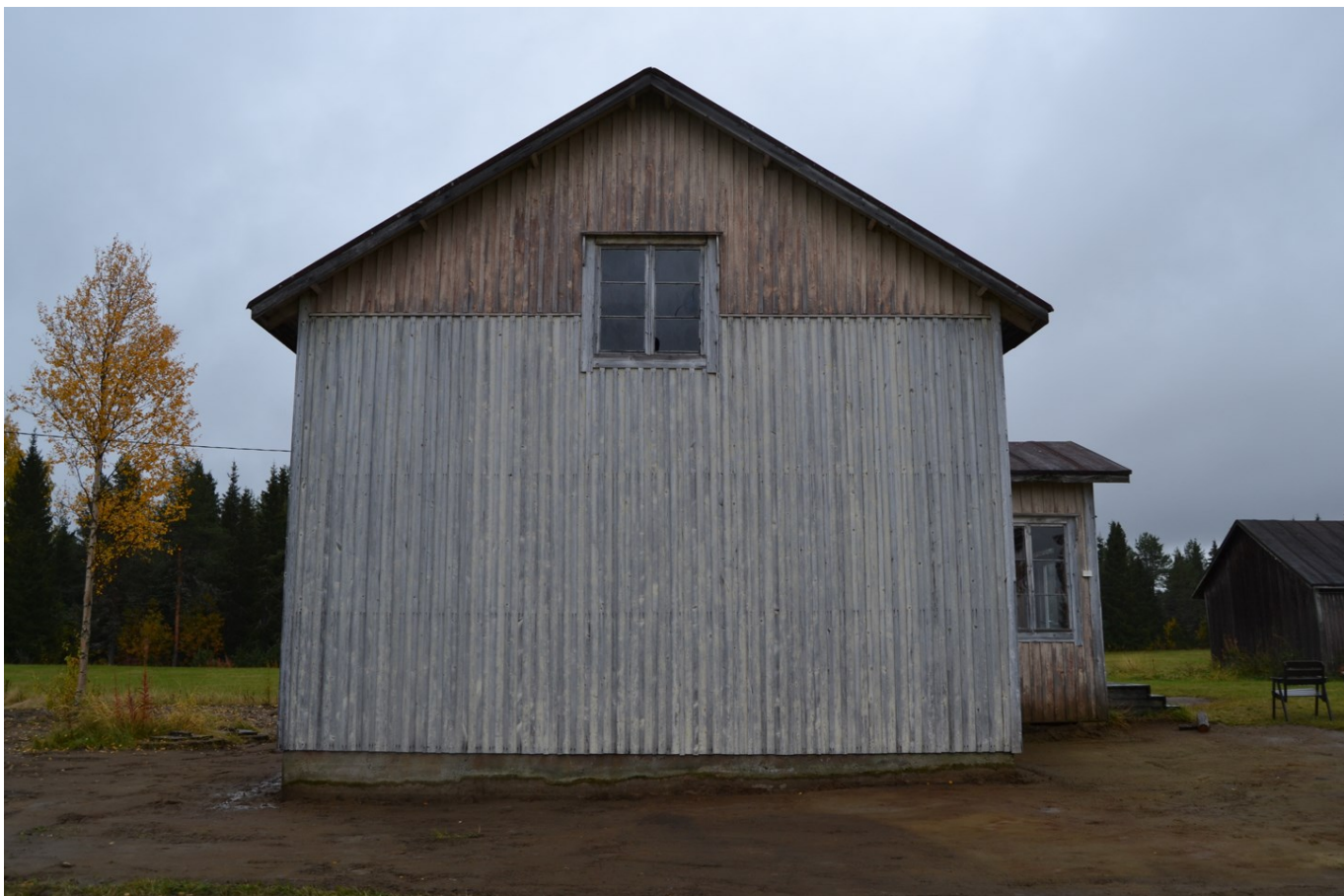
KUVA 4. Yleiskuva kohteesta (Heikkinen 2022)
