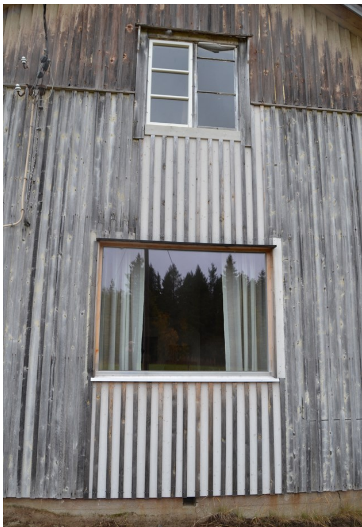
KUVA 25. Uusittu alaikkuna rakennuksen päädyssä. Kuvassa näkyy myös samalla uusittua ulkoverhous (Heikkinen 2022).
