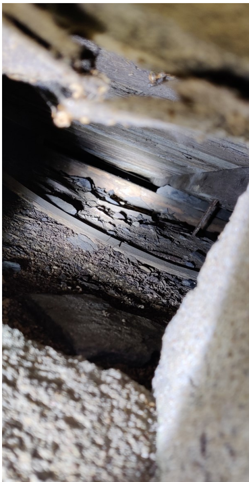
KUVA 17. Näkymä alapohjan rakenteisiin yhdestä tuuletusaukosta (Heikkinen 2022)
