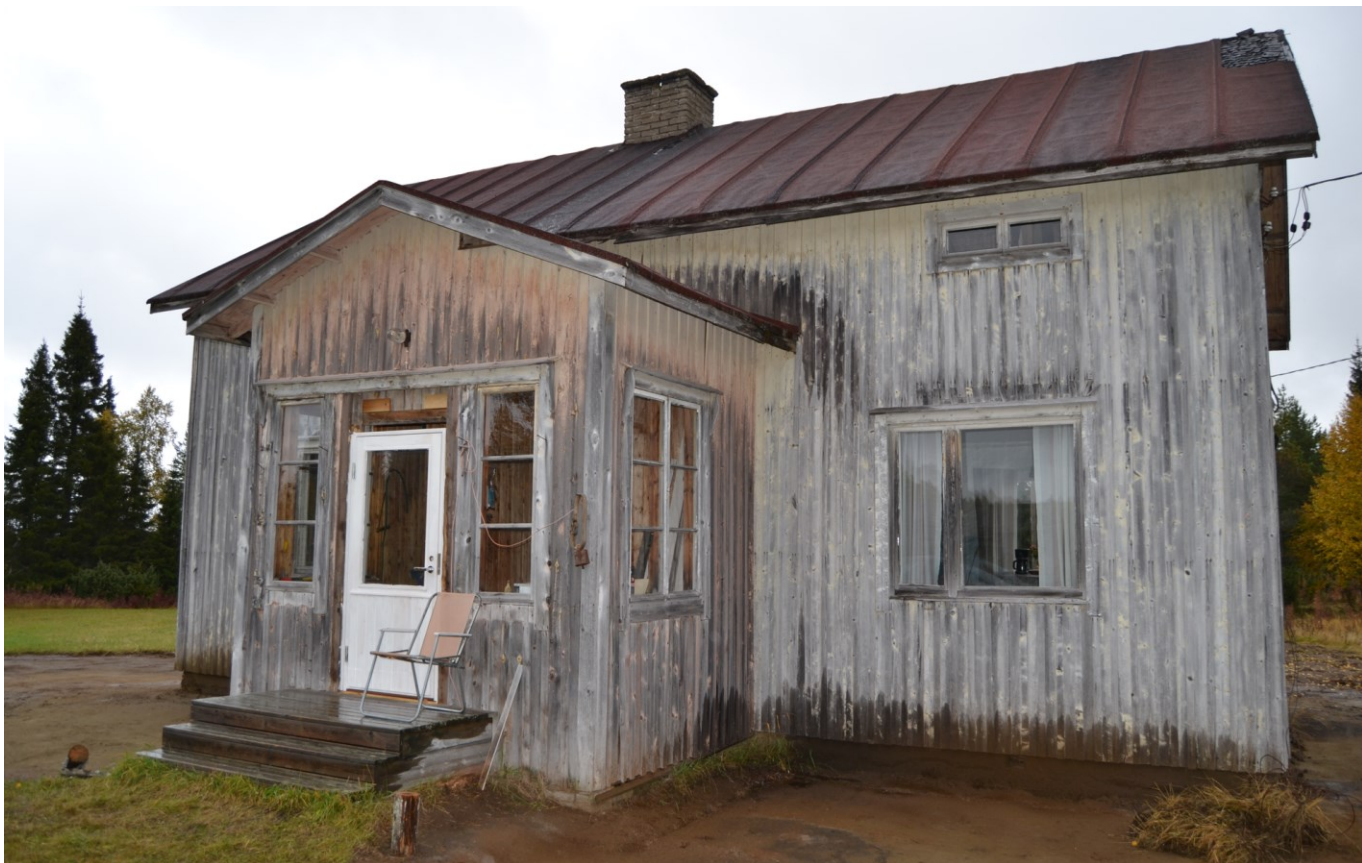
KUVA 1. Yleiskuva kohteesta (Heikkinen 2022)
