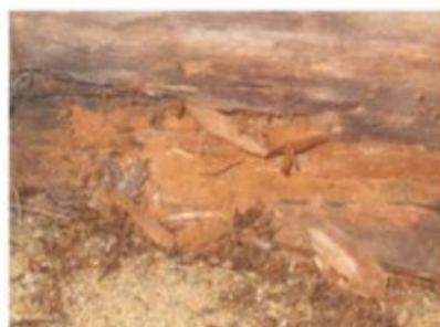
Kondenssia tapahtuu myös uusissa hirsirakennuksissa, jos seinän ja yläpohjan liitoksessa on ilmavuoto ( konvektiovirtaus ).
