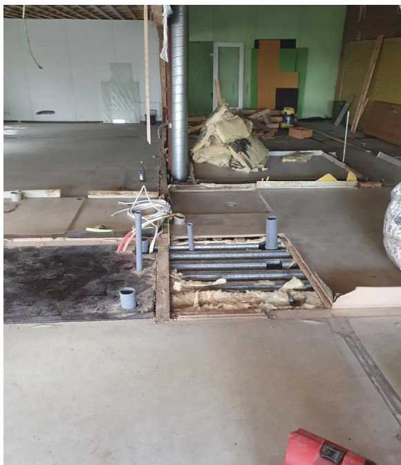
KUVA 4. Purkutöitä tehty (Laakso, 2022)
