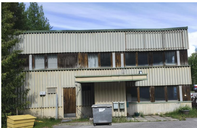
KUVA 1. Kuva hallin julkisivusta (Laakso, 2022)
