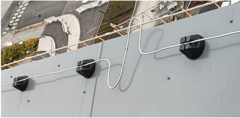
KUVA 10. Alumiinijohtimeen tehty laajennus
