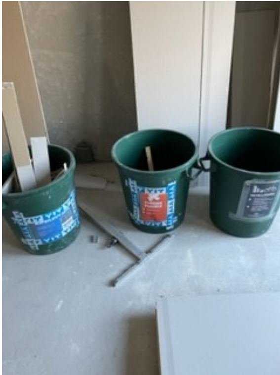
Kuva 15, Väliseinätyön vieressä olevat lajittelusaavit.
