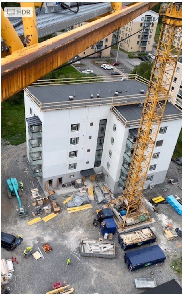
Kuva 6, Keräysastioiden sijoittelua työmaalla.
