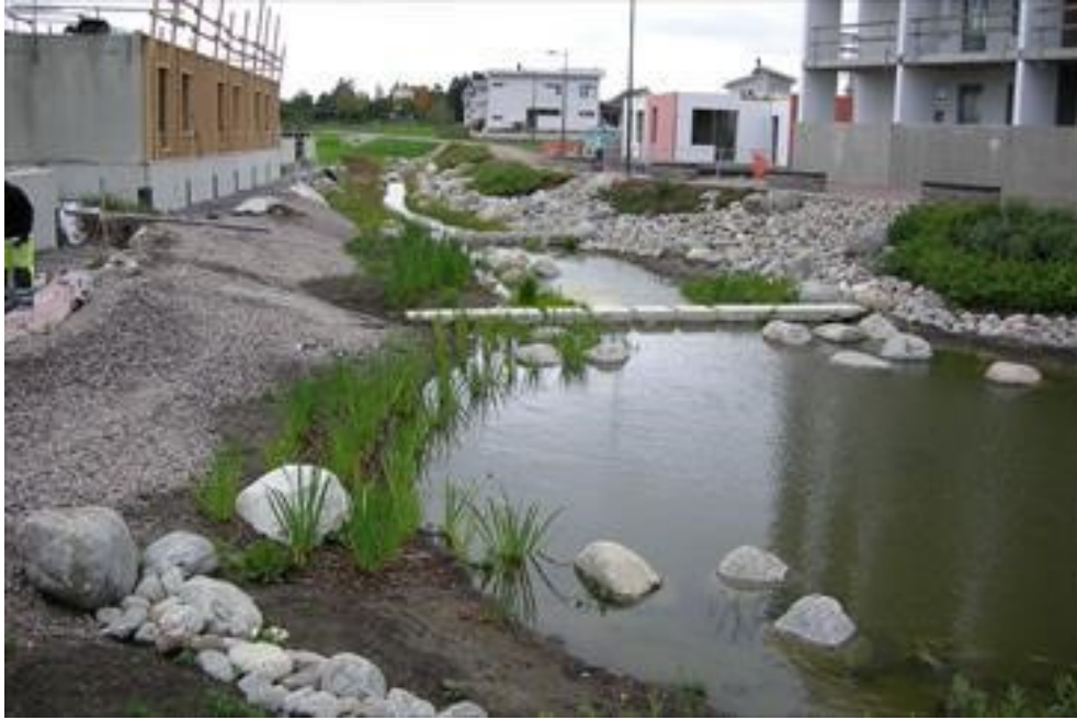
Kuva 2. Hulevesikosteikko Lepolan asuinalueella Järvenpäässä. Kuva Pinja Kasvio (Ympäristö 2020).
