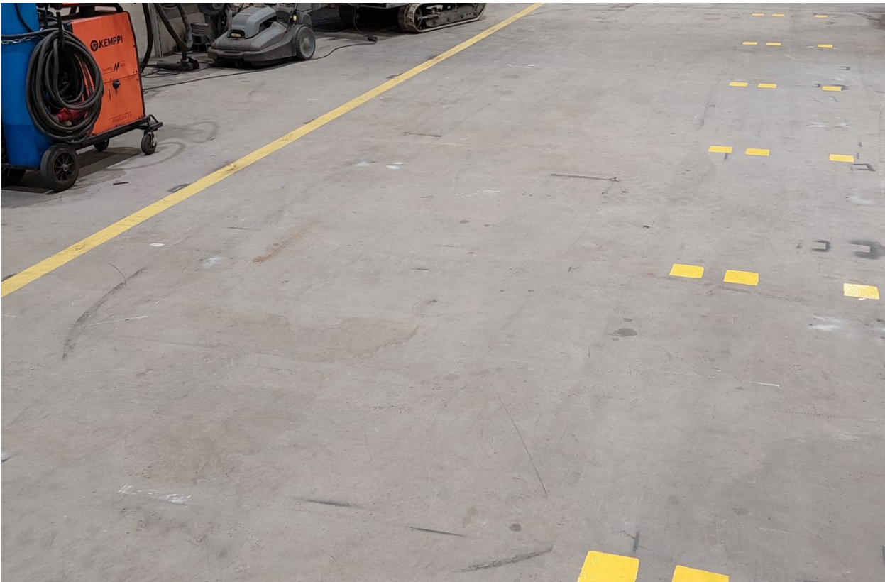
Kuvio 15. Reunaviiva ja korokepalojen sijoitusruudut ennen korkomerkitöjen mittausta
