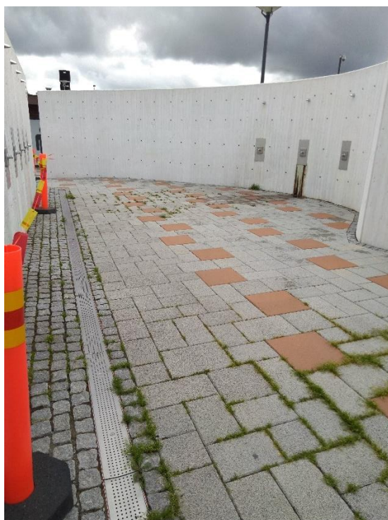
Kuva 12. Leppävaaran maauimalan ulkosuihkutilat (kuva: Sini Laine).
