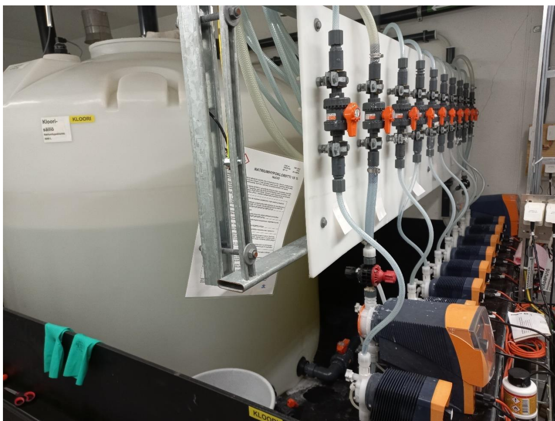
Kuva 3. Kloorin annosteluyksikkö (kuva: Jarkko Virtanen).
