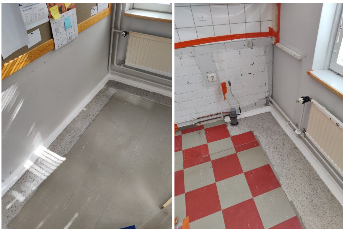
KUVAT 20 ja 21. Tiivistyskorjattuja rakenneliittymiä kohteen lohossa 1. Kohteen tiivistykset toteutettiin Elaproof-tuoteperheen tuotteilla. (Pesonen 2022, CC BY-SA)
