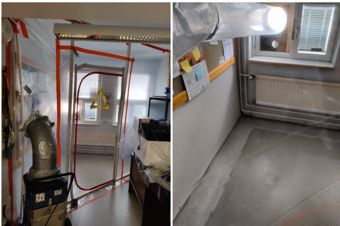
KUVAT 8 ja 9. Asbestipurkutyöt valmiita lohkoissa 1. Työalueet siistejä ja asianmukaisesti alipaineistettuja. (Pesonen 2022, CC BY-SA)
