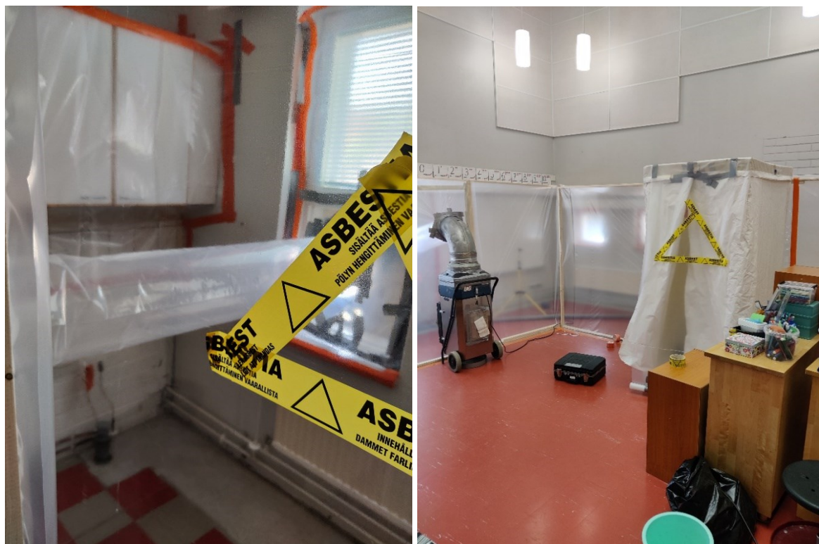
KUVAT 10 ja 11. Asbestipurkutyöt valmiita kohteen lohkoissa 2. Kuvassa 10 osasto odottaa vielä puhtausmittaustulosta. Kuvassa 11 lohko 5:n asbestipurkutyöt olivat juuri alkamassa. (Pesonen 2022, CC BY-SA)
