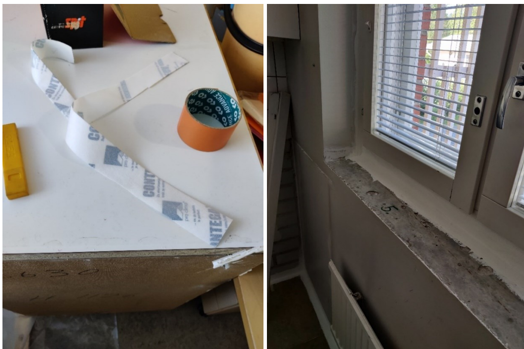
KUVAT 14 ja 15. Tiivistyskorjattu ikkunaliittymä iltapäiväkerhon tiloissa. (Pesonen 2022, CC BY-SA)
