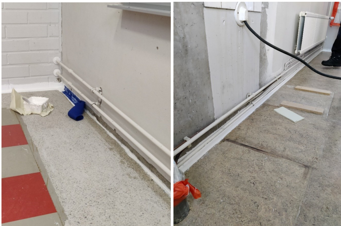
KUVAT 22 ja 23. Kuvassa 22 rakenneliittymän tiivistys käynnissä kohteen lohkoissa 3. Kuvassa 23 valmiiksi tiivistetty ulkoseinän ja alapohjan välinen liittymä iltapäiväkerhon tiloissa. (Pesonen 2022, CC BY-SA)
