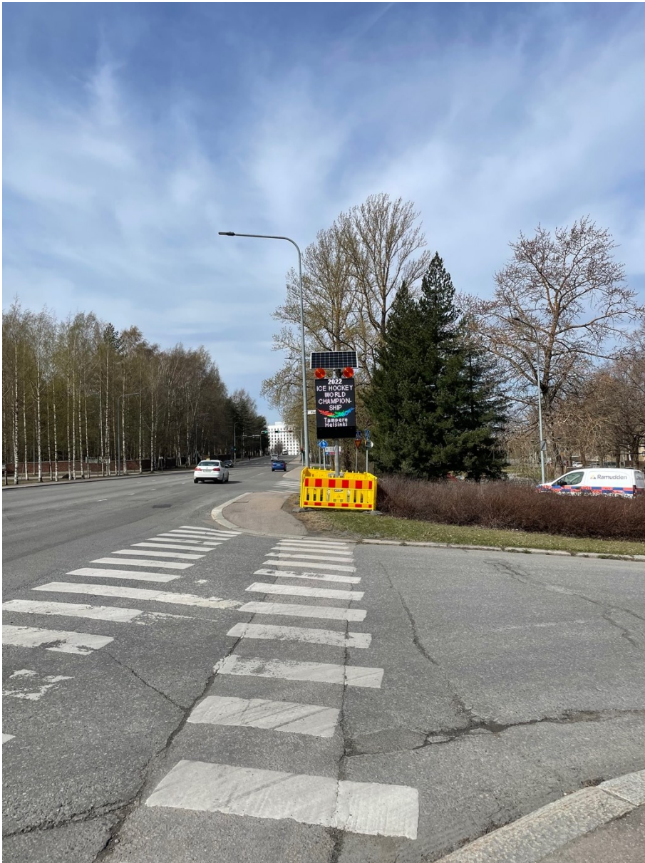
Kuva 14. VMS-taulu asennettuna. (Huuskonen, 2022)
