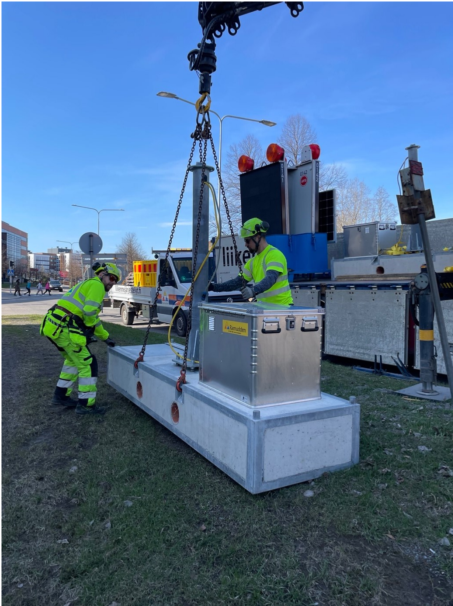
Kuva 11. Betonijalustan nosto maastoon. (Huuskonen, 2022)
