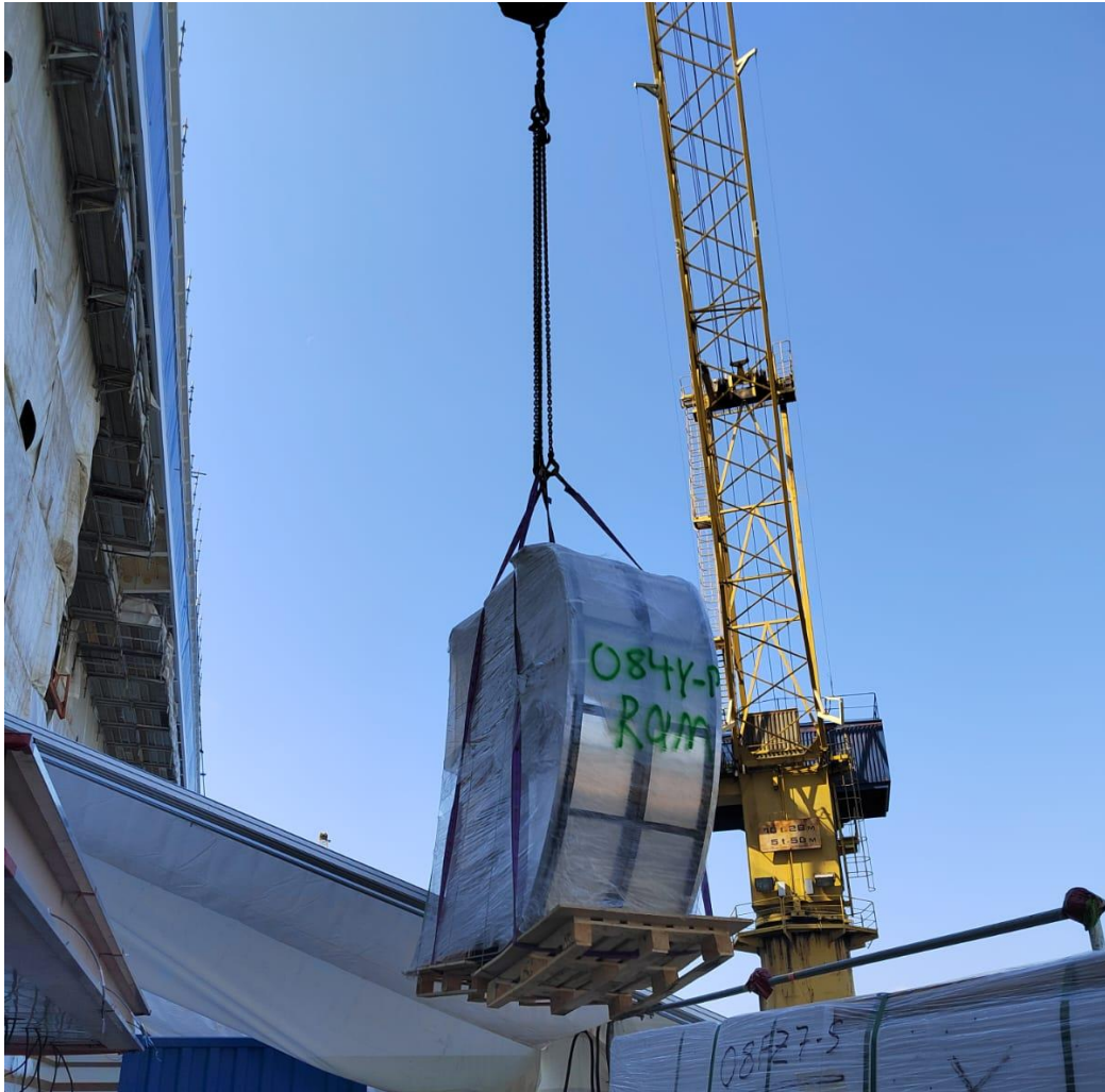
Kuva 3. Sisustusmoduulin nosto laivaan
