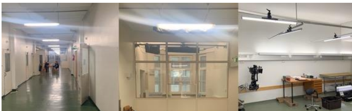
Figur 3. Bildkollage från ljussättandet. Från vänster till höger: Väntsalen, Receptionen och läkarens rum. Foto: Sebastian Lindroos 2019.
