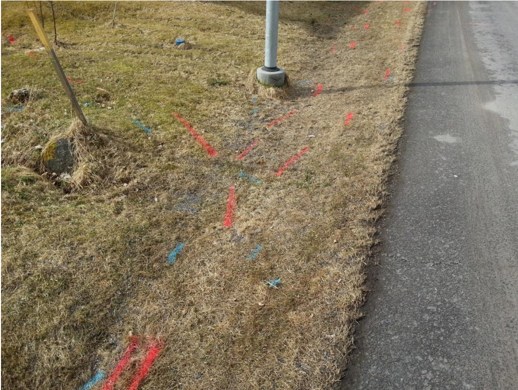
KUVA 5. Kaapelinäyttö merkintöjä katu-alueella. (17.)
