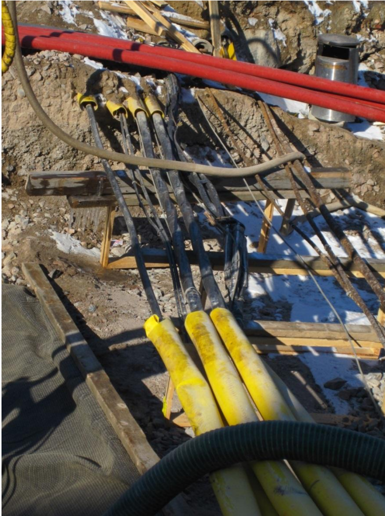
KUVA 9. Esimerkkejä hyvästä kaapelituennasta 2 (15, s.17)
