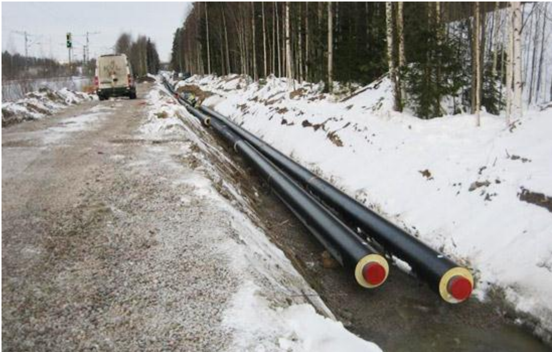
KUVA 12. Kaukolämpöelementti kaivannossa. (23.)
