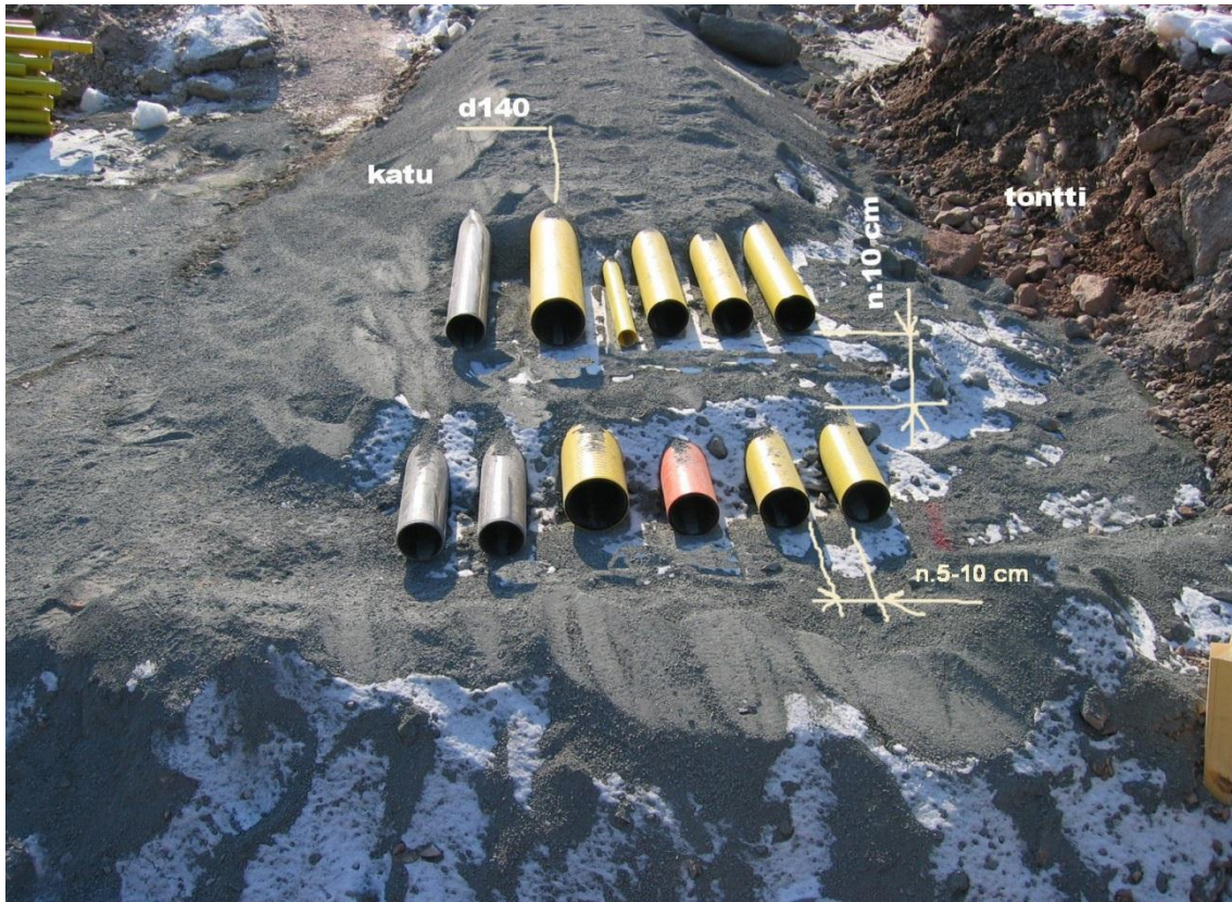
KUVA 7. Esimerkki kaapeliputkituksista (15, s.15)
