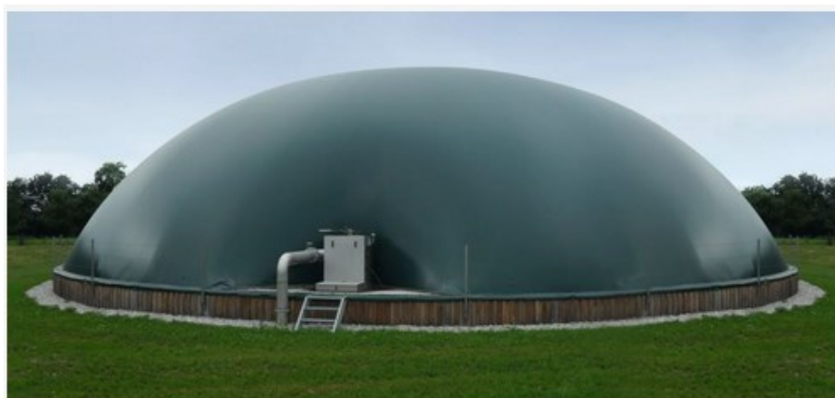
KUVA 13. Kaksoiskalvo välivarasto, jossa on kaasun ulostulo. (Zorg biogas)
