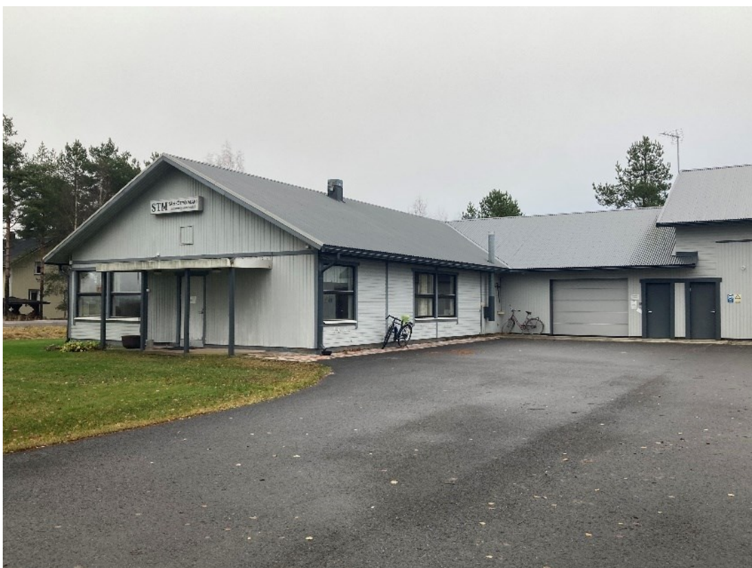
Kuva 1. Sähkötyö Mäki Oy
