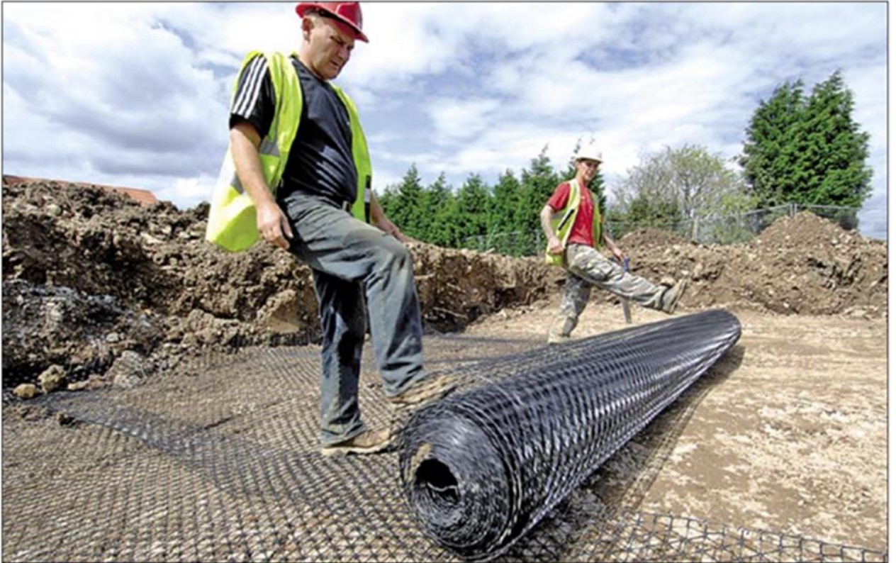
KUVA 13. Muovisen lujiteverkon asentaminen on helppoa (8)
