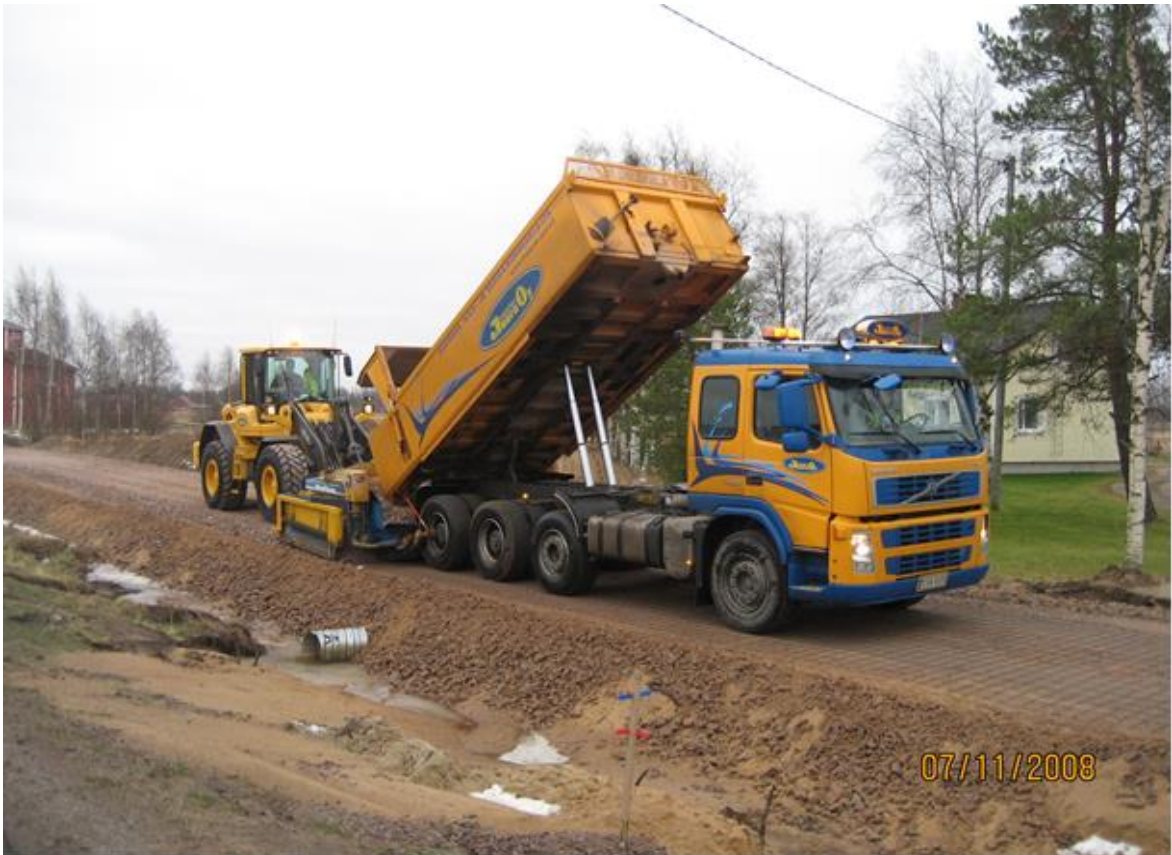
KUVA 12. Teräsverkko asennetaan yleensä noin 20 cm:n syvyyteen
