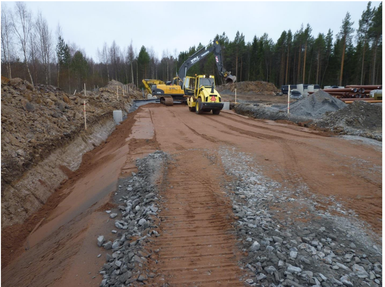
KUVA 3. Suodatinhiekan ja jakavan kerroksen vastaanottoa
