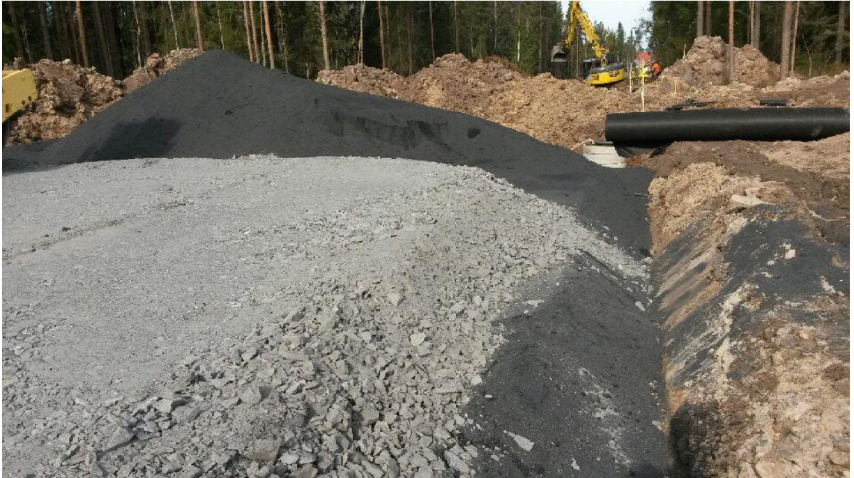
KUVA 5. Rakennekerrosten vastaanottoa OKTO-rakenteisella tiellä
