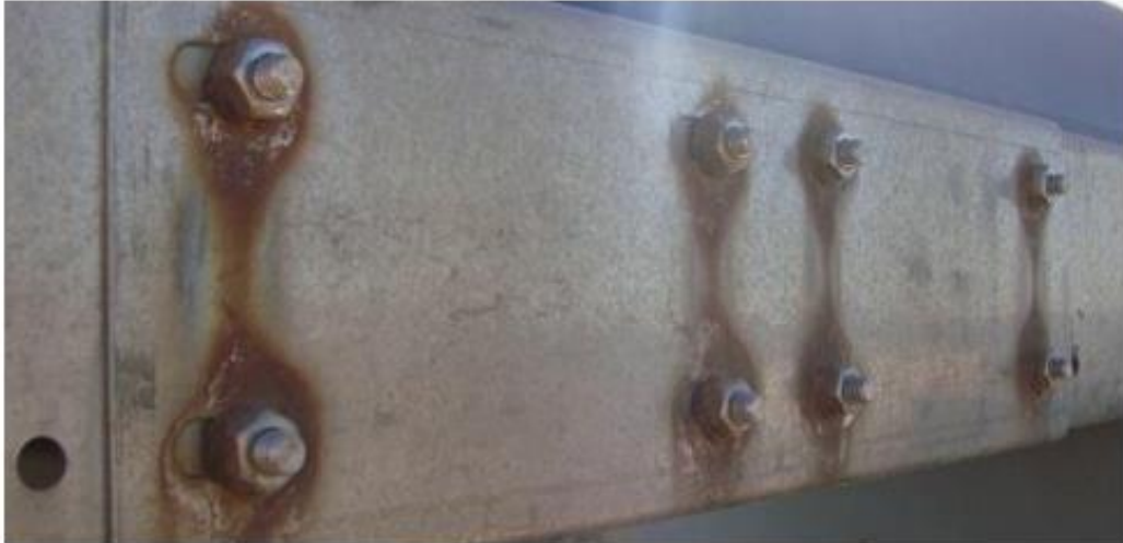
Kuva 5. Galvaaninen reaktio, joka johtuu ruostumattoman teräslevyn kosketuksesta tavalliseen hiiliteräkseen [5].
