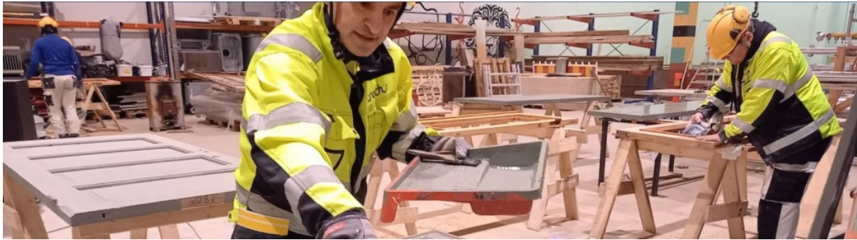
Pispalan koulun puuovien kunnostusta. Kuva: Reeta Alho
