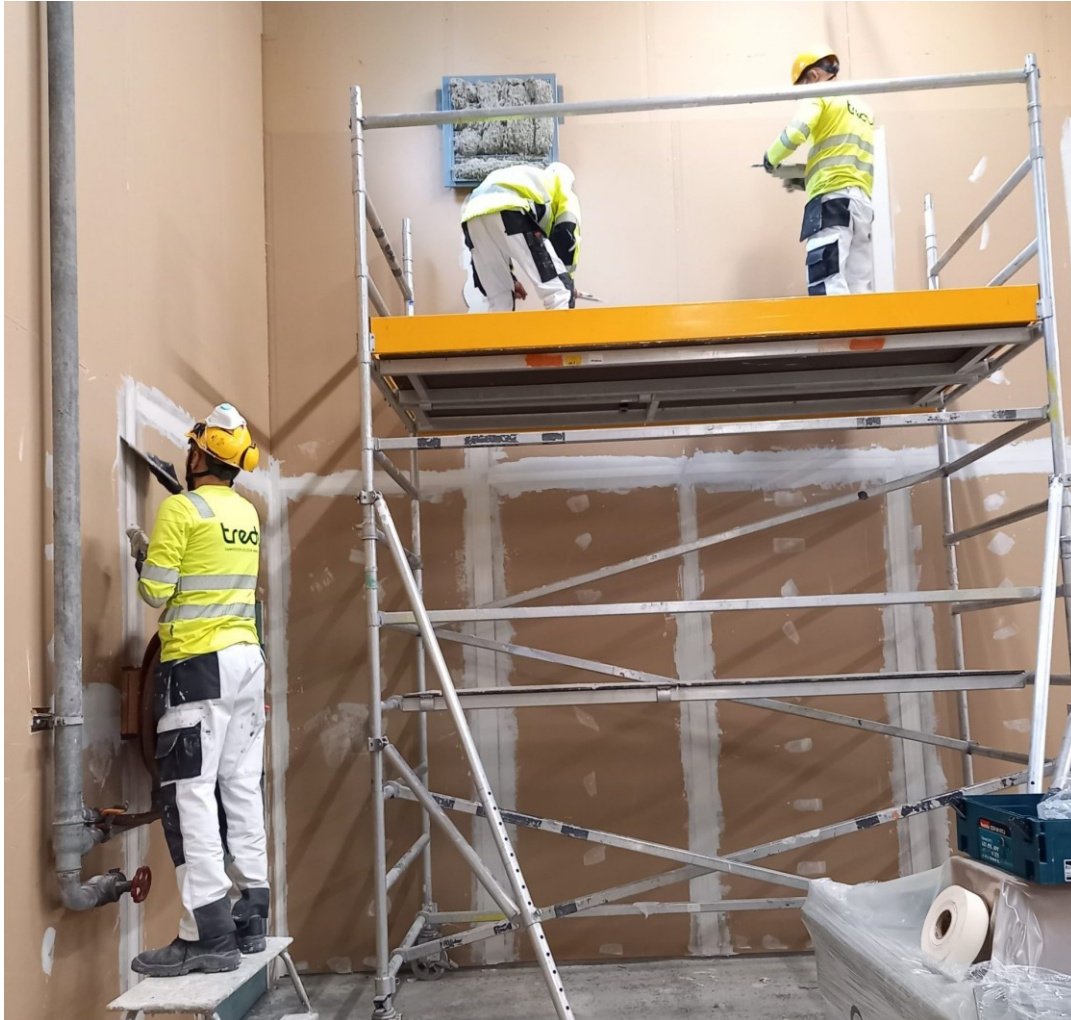
Hiedanrannan skeittihallin kipsilevyjen tasoitusta. Kuva: Reeta Alho
