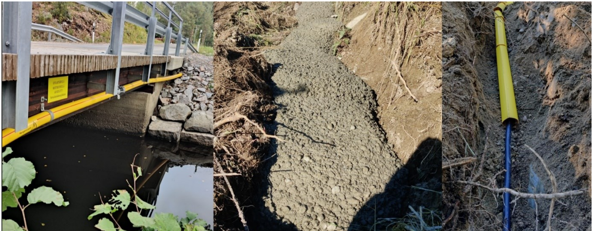
Kuva 1. kaapelien suojauksia eri menetelmillä
