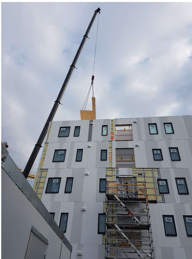
KUVA 13. Valokuva, suojakatto nostettiin elementtien asennuksen ajaksi pois. (Rakennustoimisto Eero Reijonen Oy 2018.)
