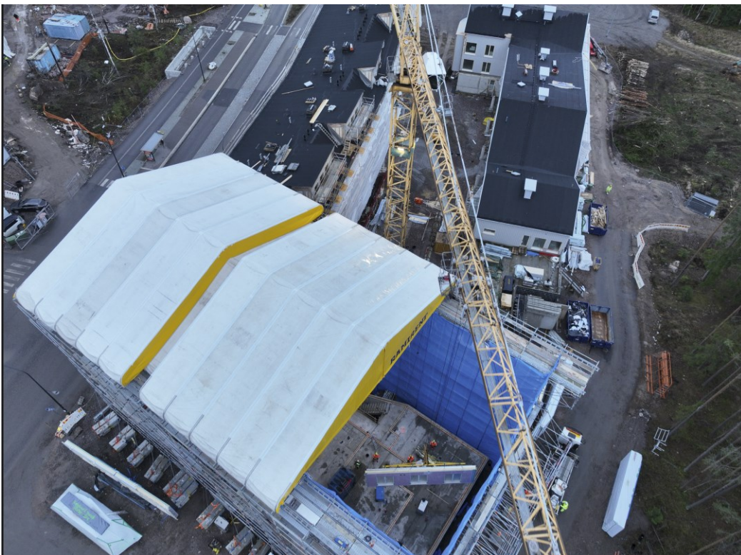
Kuva 1 rakentamista säältä suojassa (Ramirent)
