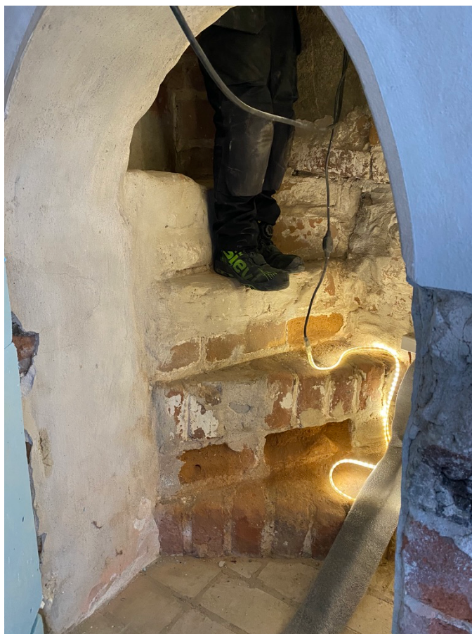
KUVA 5. Kulkureitti yläpohjan onteloon seinärungon sisällä (Laukkanen 2022)
