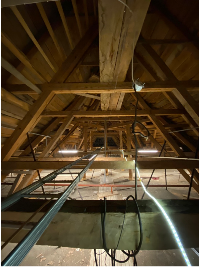
KUVA 4. Kuva yläpohjan ontelosta (Laukkanen 2022)
