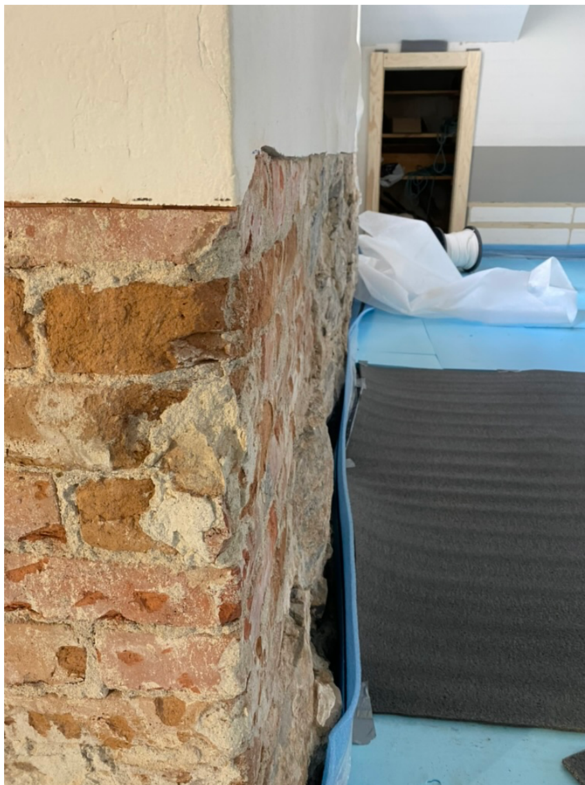
KUVA 6. Seinän runkorakenne ja purettu rappaus (Laukkanen 2022)
