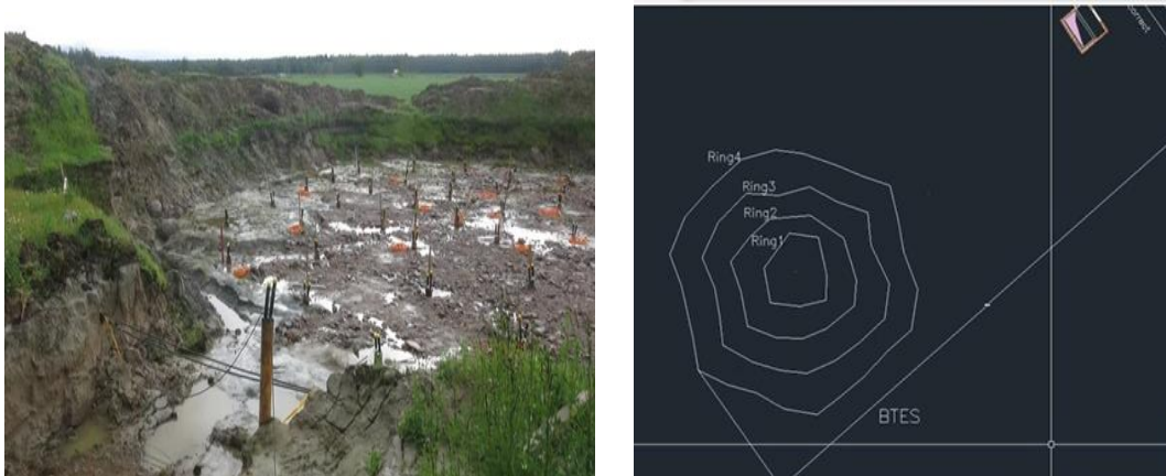
Kuva 18. Vasemmalla lämpökaivot ennen päällisosan valmistusta ja oikealla kehien rakenne (Sander 2022).
