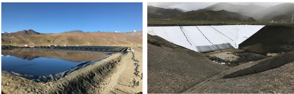
Kuva 9. Kuvia allasvaraston rakennusvaiheista (Aalborg CSP 2022).
