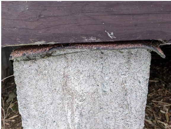
Kuva 8 Betonipilarien ja hirsirungon välissä on kapilaarikatkona bitumi-huopa.
