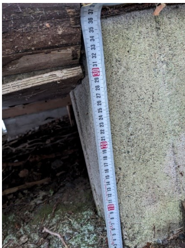
Kuva 9 Hirsi on lovettu pilarin kohdasta.
