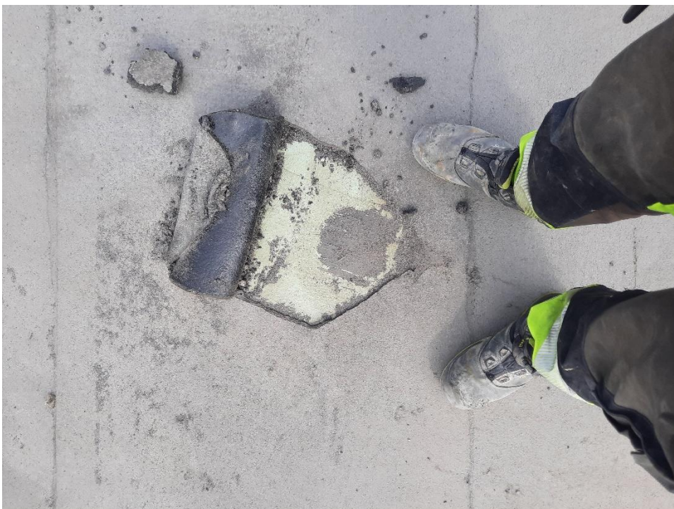
Kuva 5. Avattu bitumikermin kupru (kuva Oskari Rämö)
