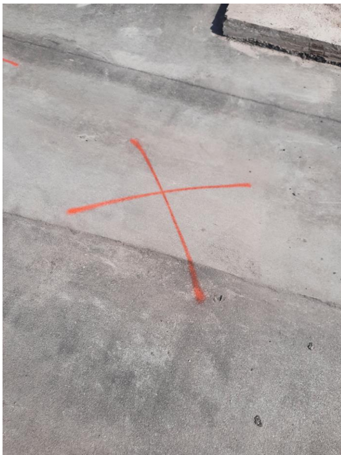
Kuva 4. Yksittäinen Osmoosin aiheuttama kupla vedeneristeessä (kuva Oskari Rämö)
