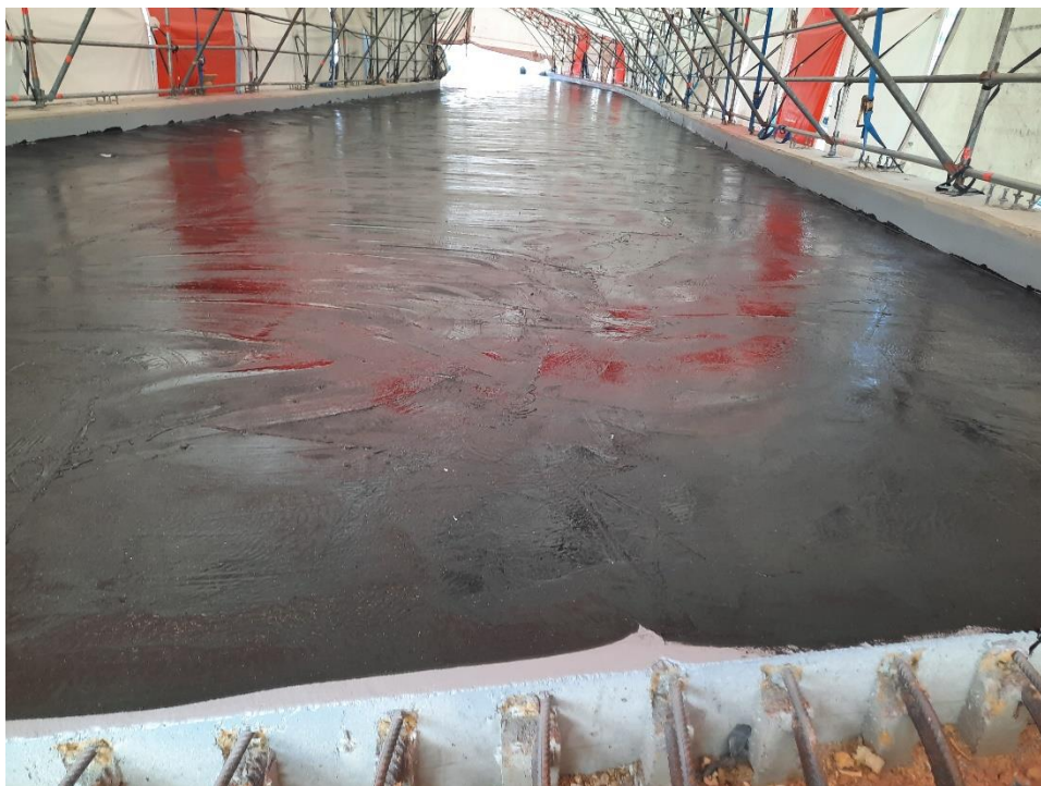
Kuva 8. Pinta vedeneristystöiden jälkeen sääsuojan alla kuva Oskari Rämö)
