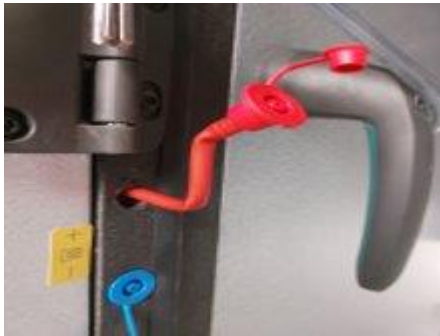
Kuva 9. Paineanturin letku on asennettu väärin ja siinä ei kulkenut ilma kunnolla, jolloin myös mittaus näytti väärin.
