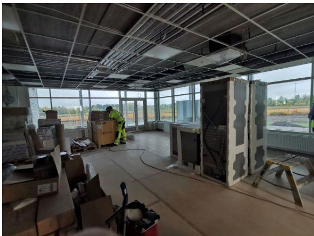
Kuva 1. Lokakuussa 2022 Koisoniityn olohuonetila oli rakennusvaiheessa ja toiminnan suunnittelu käynnistynyt.
