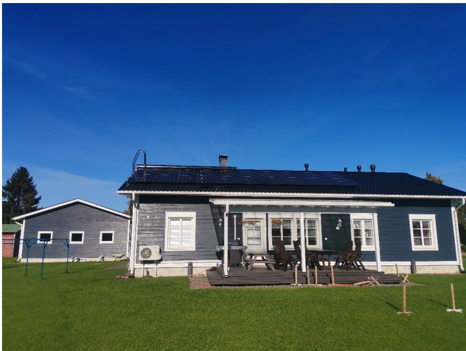
Kuva 13. Paneelit katolle asennettuna (Hautamäki, 2022).
