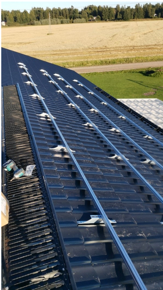
Kuva 12. Kiinnityskiskot asennettuna (Hautamäki, 2022).
