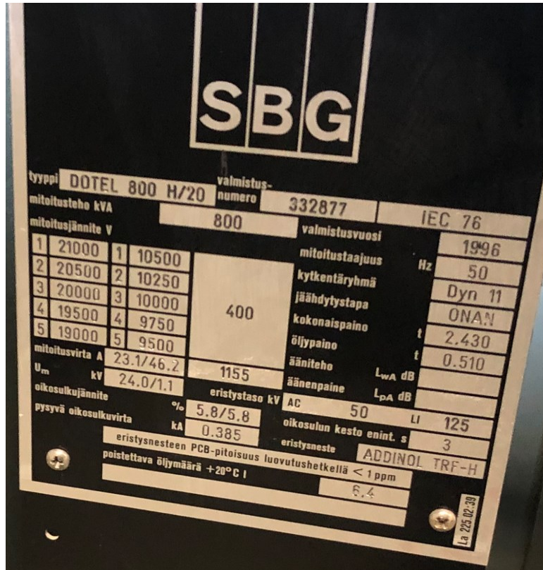
Kuva 6. Edellisessä kuvassa esitetyn muuntajan tyyppikilpi.
