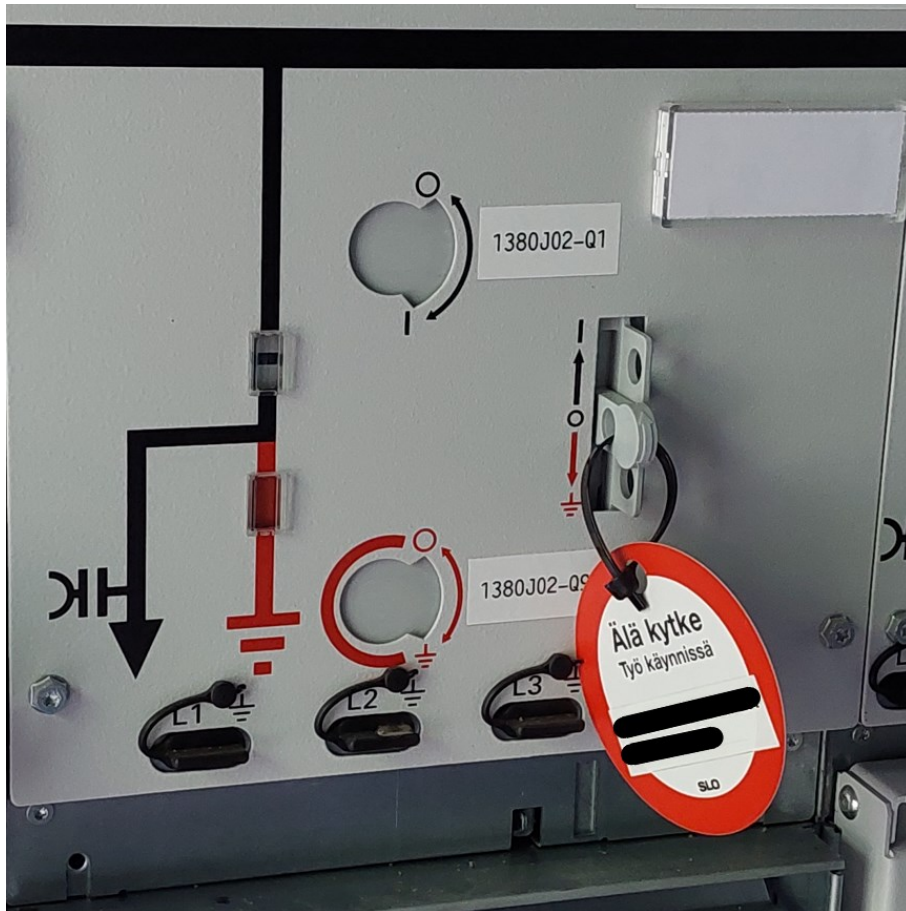
Kuva 13. Esimerkki varoituskilvestä RMU-kojeistossa.
