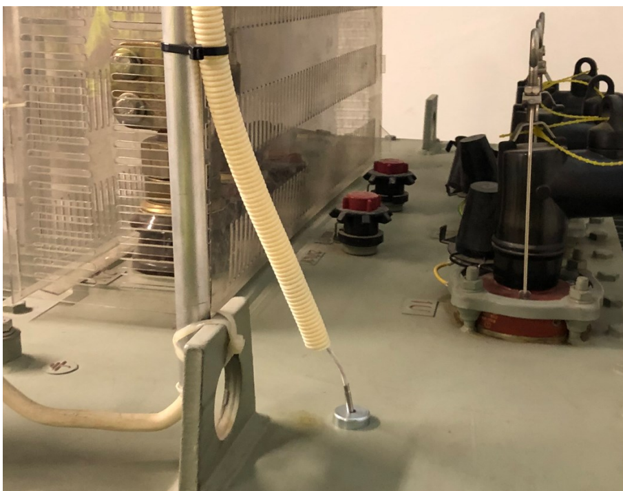
Kuva 5. Jännitteen vaihtokytkimiä on erilaisia.
