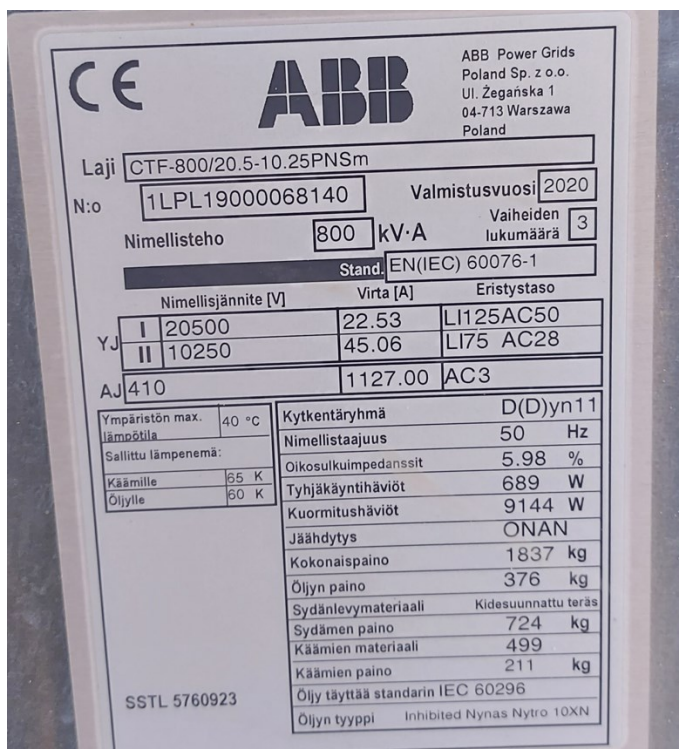
Kuva 4. Edellisessä kuvassa esitetyn muuntajan tyyppikilpi.
