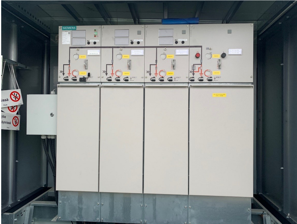
Kuva 9. Siemensin RMU-kojeisto.
