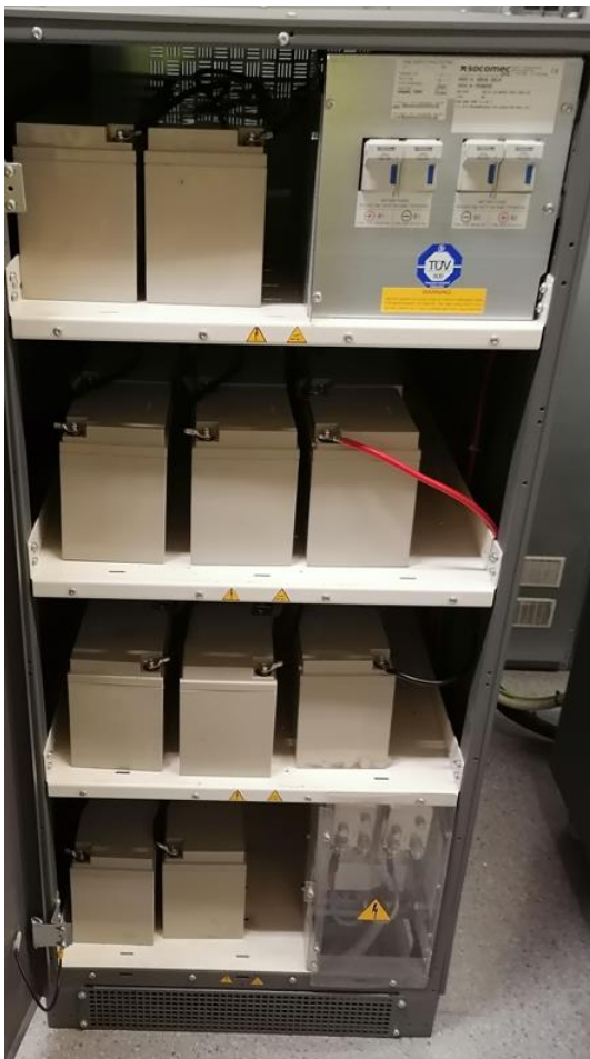
KUVA 29. Akkukapiini kojeistossa 4.
