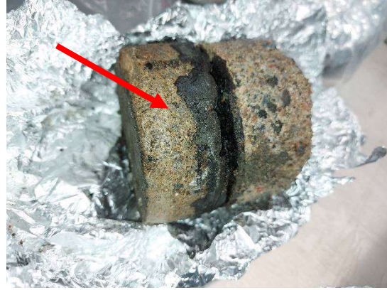
Kuva 20. Autotallien alapohjarakenteiden pintalaatat sisältävät vaarallisen jätteen raja-arvon ylittäviä pitoisuuksia öljyhiilivetyjä.
