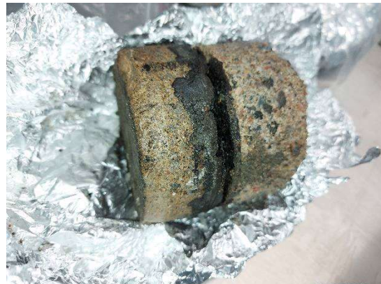
Kuva 25. Alapohjan rakenneavaus RA-AP2.
