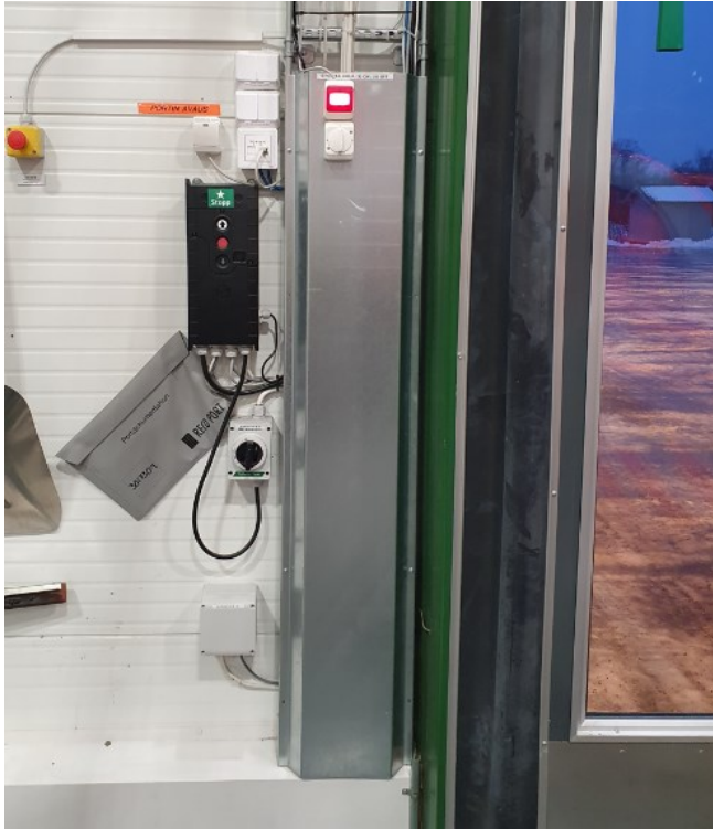
Kuva 10. Sähköasennukset ovien välissä.
