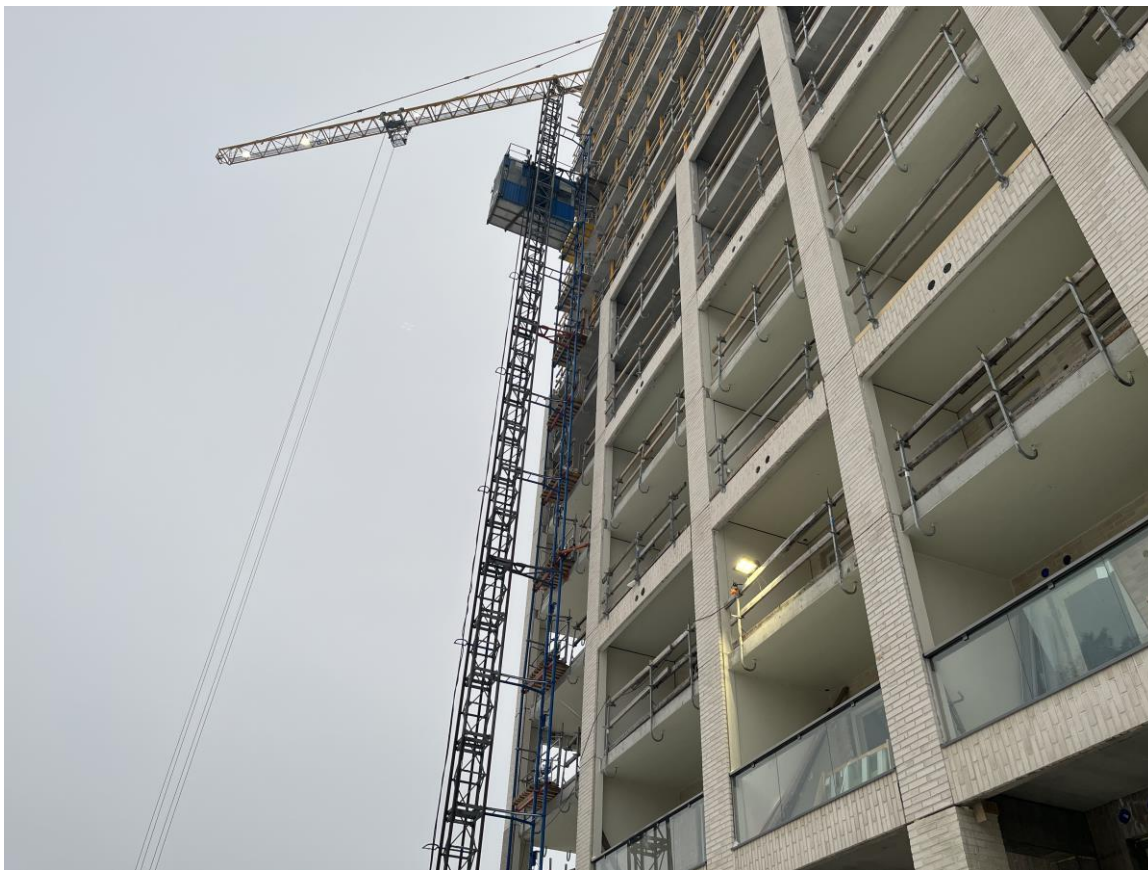
Kuva 4. Rakennushissi JM Suomen työmaalla Leppävaarassa.
