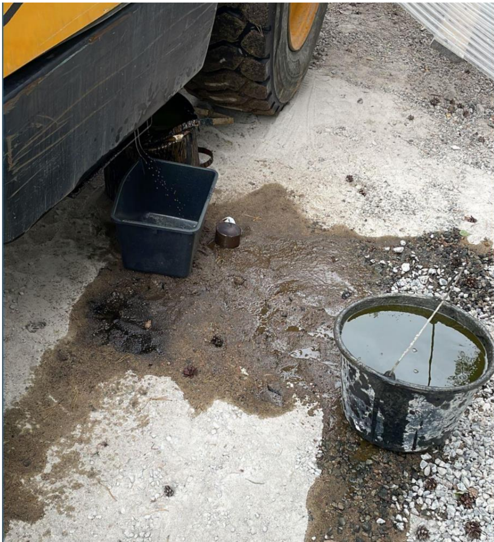
Kuva 7. Hajonneen letkun aiheuttama öljyvuoto.
