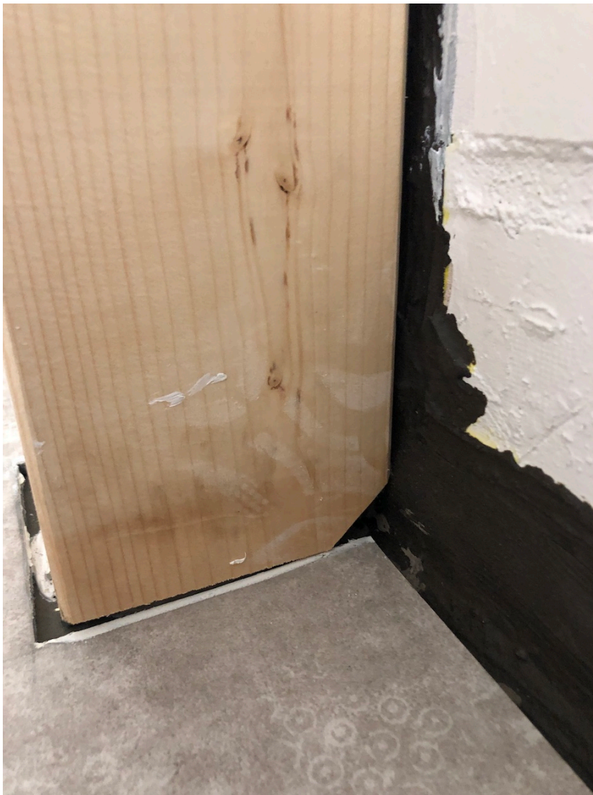
KUVA 8. Uudelleen korjattu lattia-seinäpinnan tiivistys
