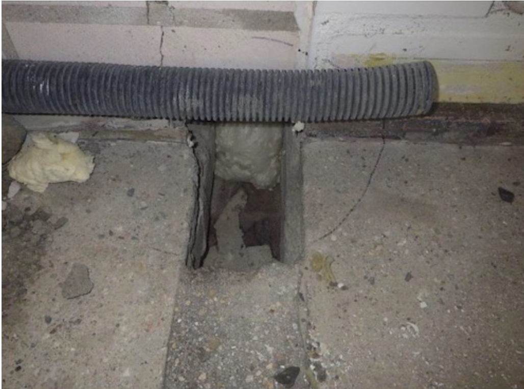
KUVA 7. Väliseinän alta betonivalussa ollut puu poistettu
