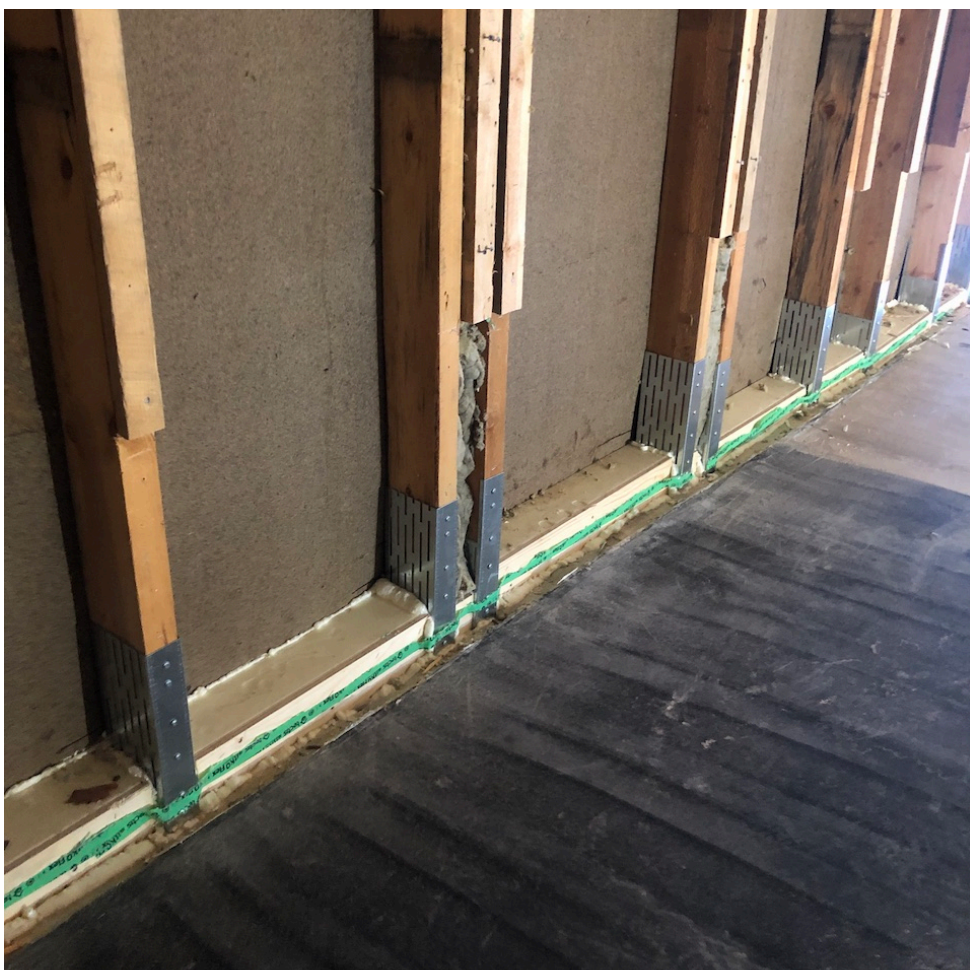
KUVA 5. Aiemmin tehty ulkoseinien kengitys
