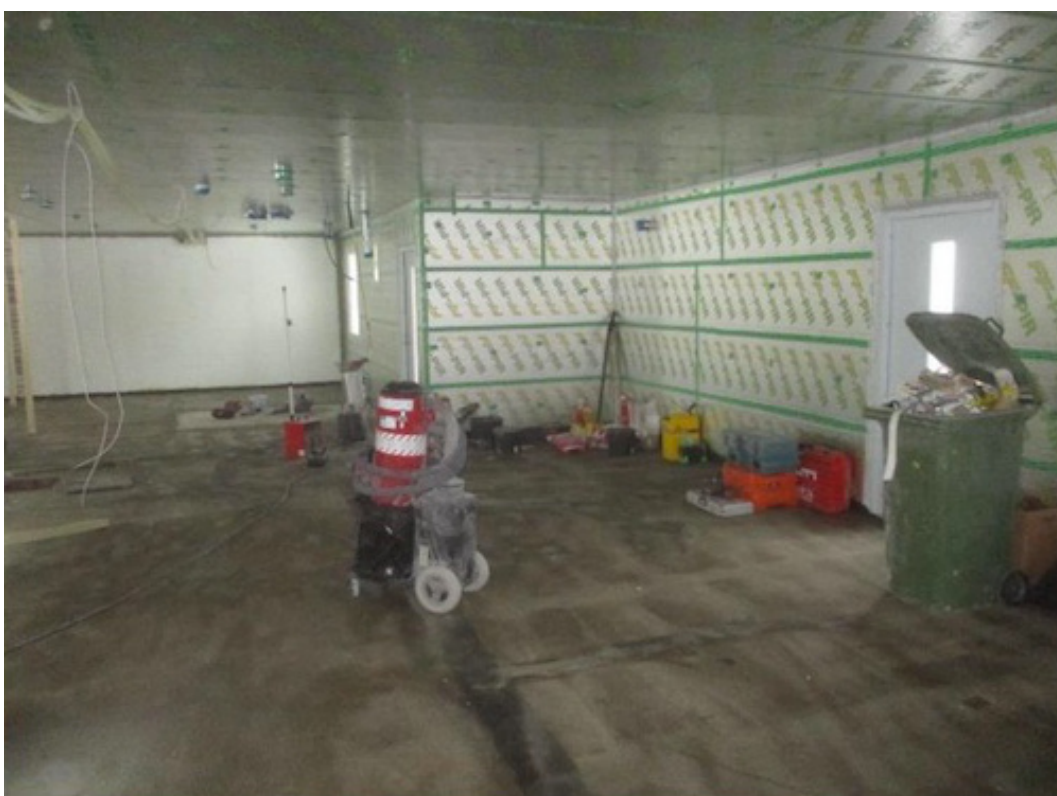
KUVA 20. FF-PIR -levyt asennettu ja saumat teipattu
