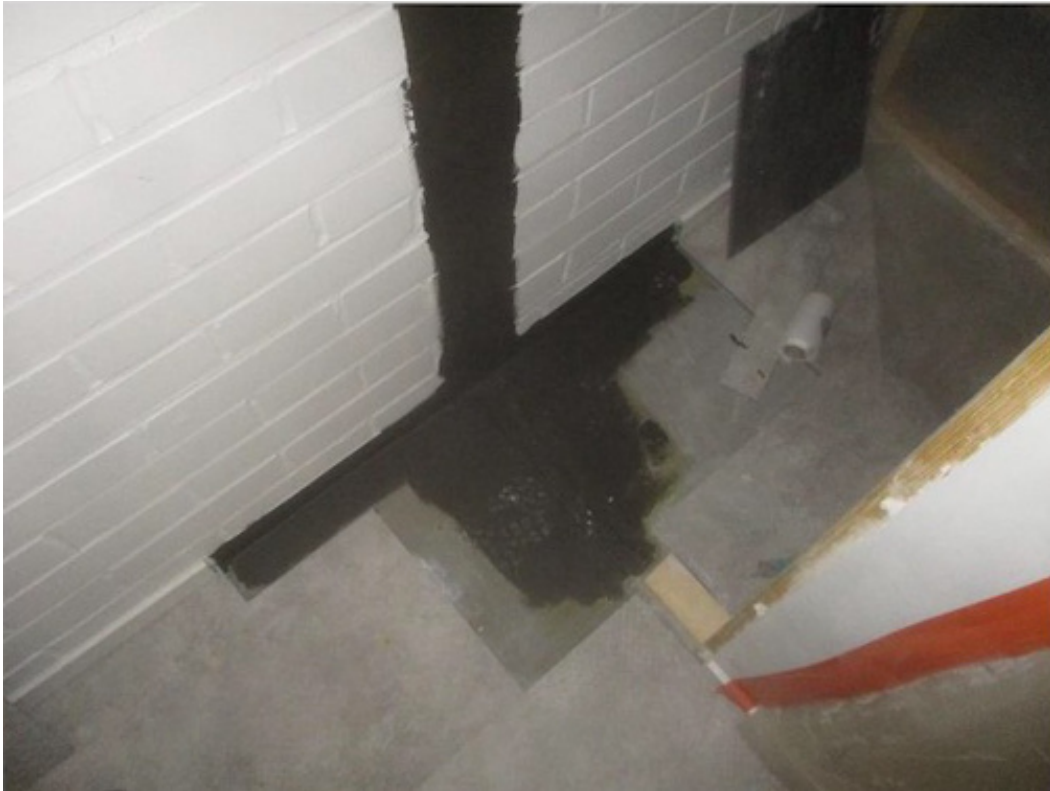
KUVA 22. Tiivistykset korjattu vuotokohdassa
