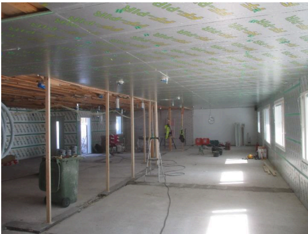
KUVA 19. FF-PIR -levyt asennettu, mutta saumojia ei vielä teipattuna
