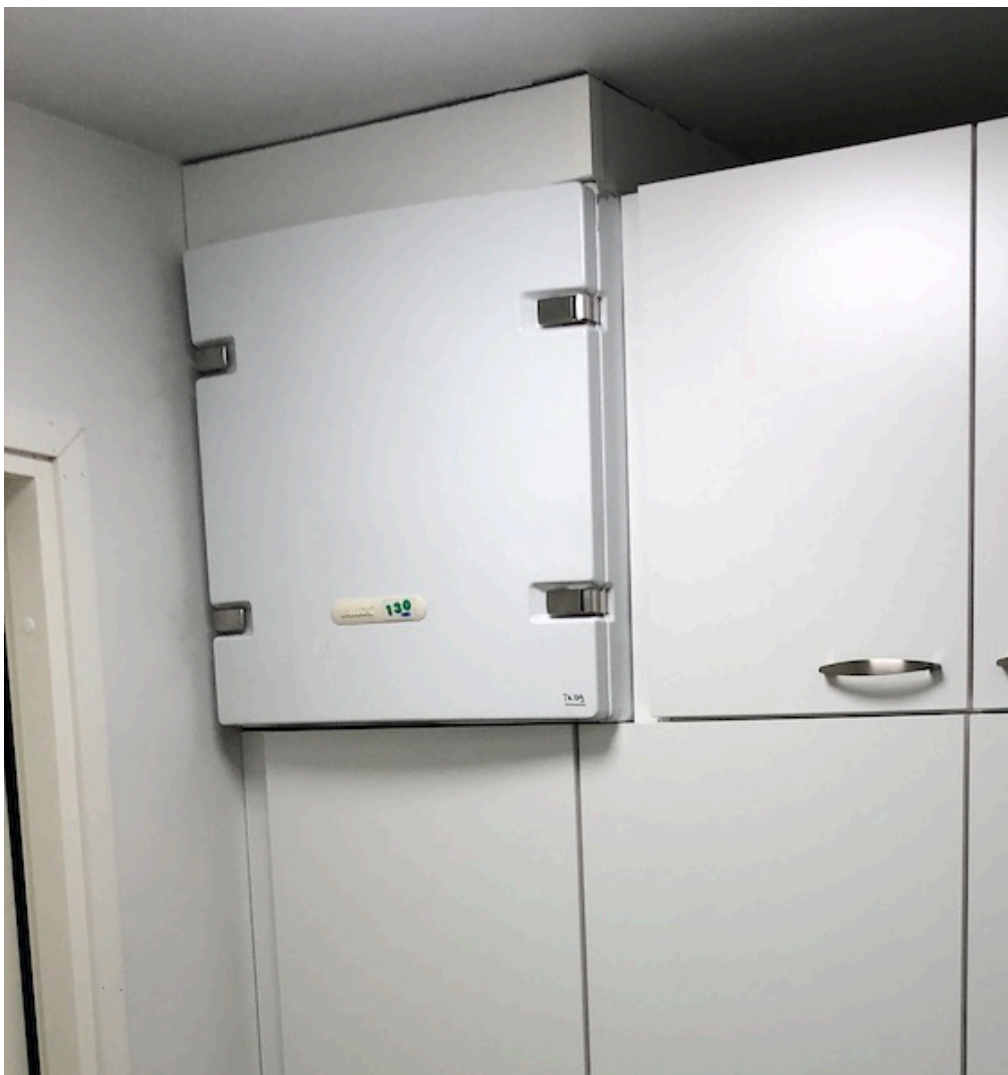
KUVA 10. Huollettu IV-kone asennettuna takaisin paikalleen
