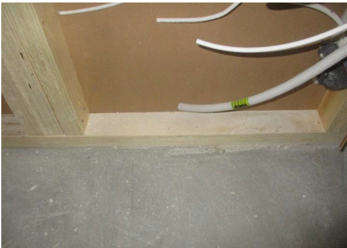
KUVA 11. Väliseinien rungoissa oleva pöly puhdistettava ennen villoitusta ja levytystä
