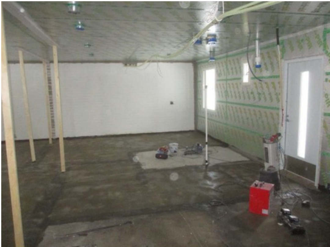
KUVA 18. Höyrinsulkukäsittely lattiaan tehty Ardex EP 2000
