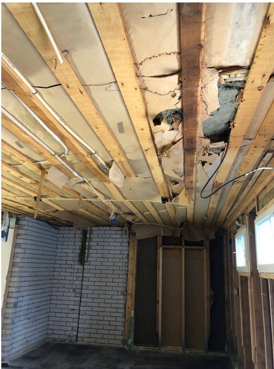
KUVA 6. Yläpohjan alapinta ennen remonttia
