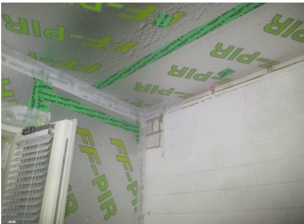
KUVA 21. Sitko Flex höyrynsulkuteipillä tiivistettyjä liitoksia
