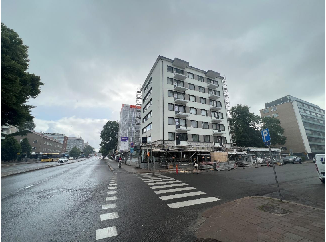
Kuva 3. Asuinkerrostalon telinepurku käynnissä
