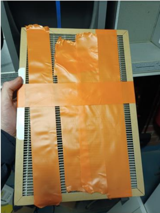
KUVA 56. Tuloilmasuodattimen lisäteippaus testin toisessa osassa
