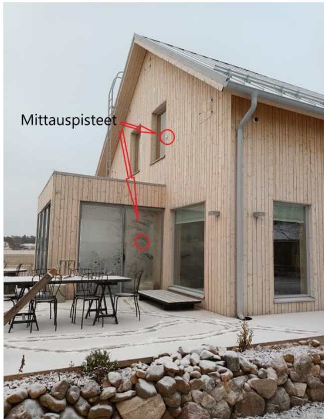
KUVA 34. Mittauspisteet ulkoilmassa julkisivussa
