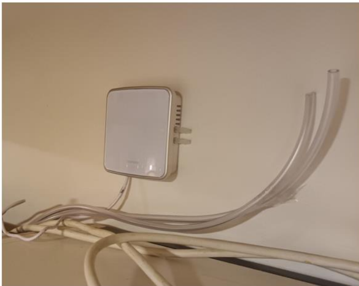
KUVA 33. Mittausanturi asennettuna sisäseinään, mittausletkut tässä vaiheessa vielä kiinnittämättä
