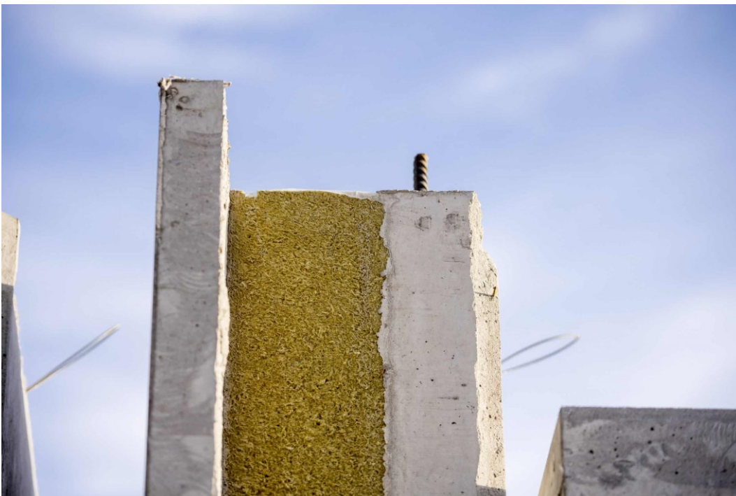
Kuva 4. Sandwich-seinäelementti (Kovabetoni, i.a.)
