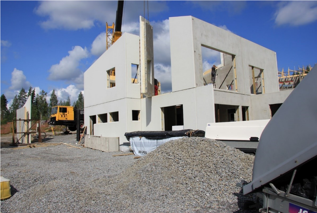
Kuva 5. Omakotitalon betonielementtien asennusta (Hintikka, 2013)
