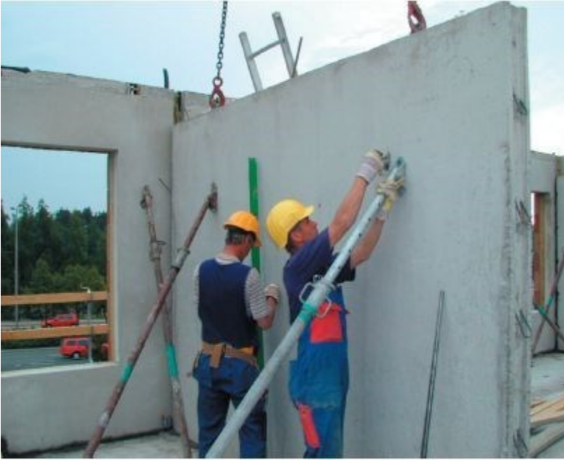
Kuva 8. Seinäelementin tukeminen asennusvaiheessa (Betoniteollisuus, i.a.).
