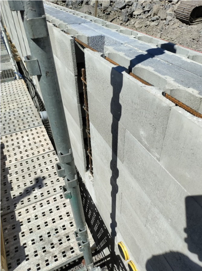
Kuva 3. Lämpöharkkoja ladottuna sekä raudoitettuna (Hakomäki, 2021).
