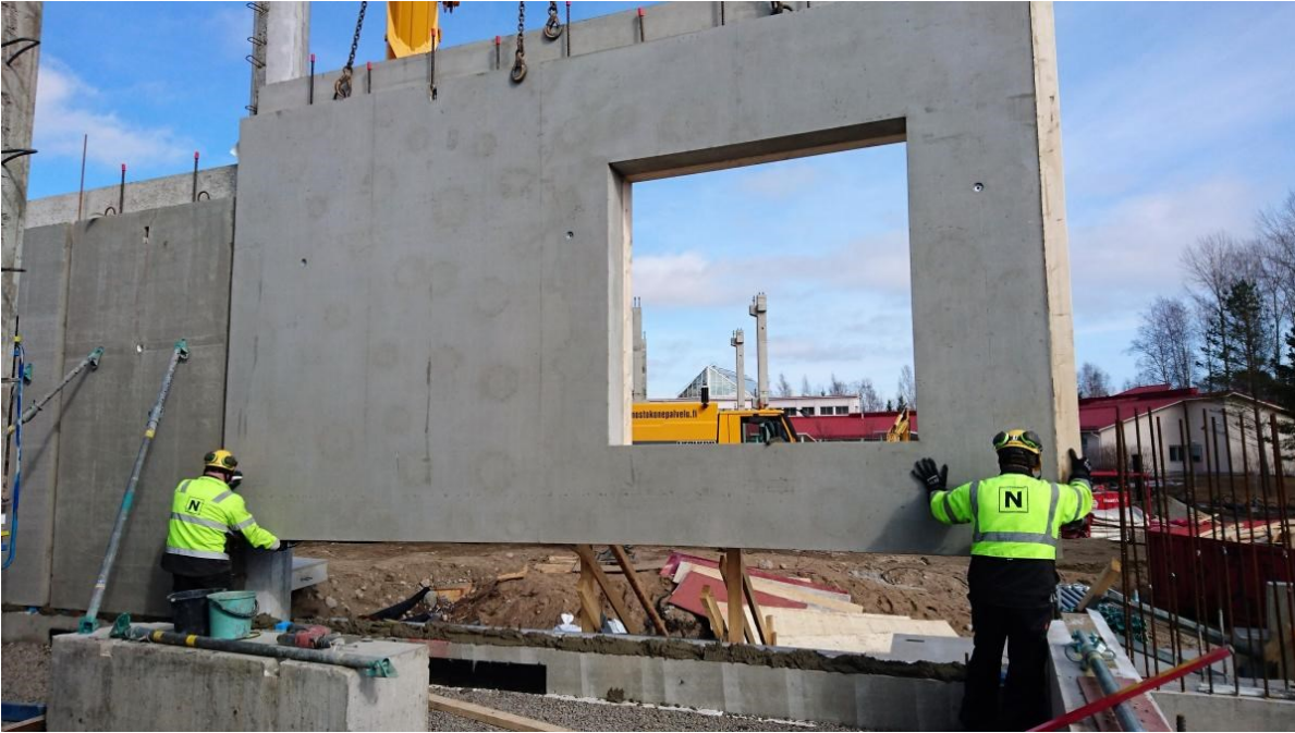
Kuva 7. Betonielementtien asennusta työmaalla (Nostokonepalvelu, i.a.).
