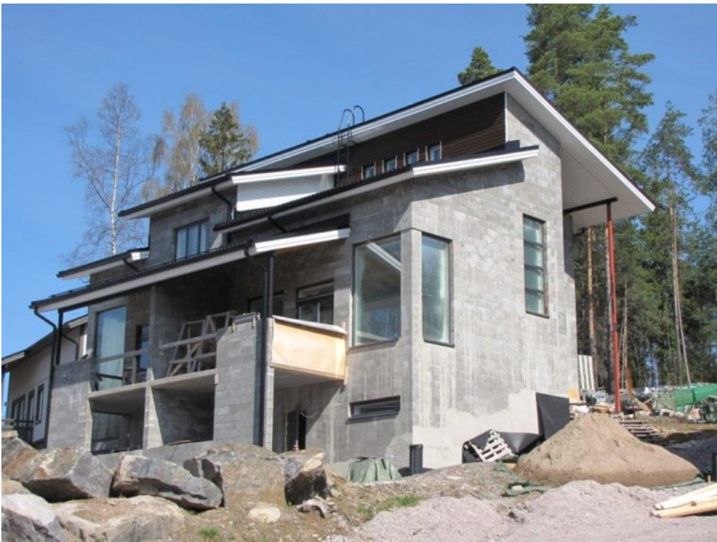
Kuva 1. Rakenteilla oleva harkkotalo (Betoniteollisuus, i.a).
