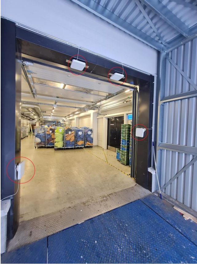
Kuvio 8. RFID-antennit. Yhdellä ovella antennoja on yhteensä neljä, joista kaksi sijaitsee oven yläpuolella, sekä yhden oikealla sekä vasemmalla
