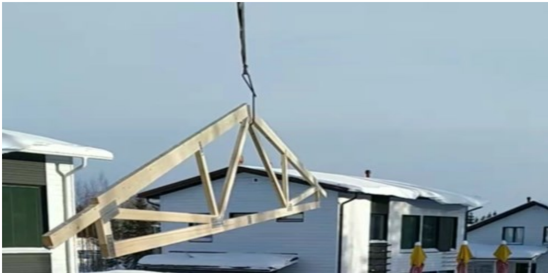
Kuva 6. Kattoristikoiden nostaminen
