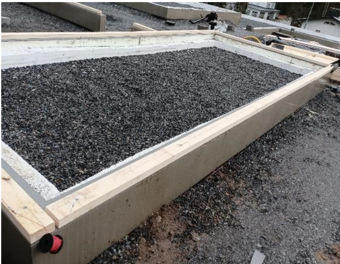
Kuva 4. Alaohjauspuiden kiinnitys
