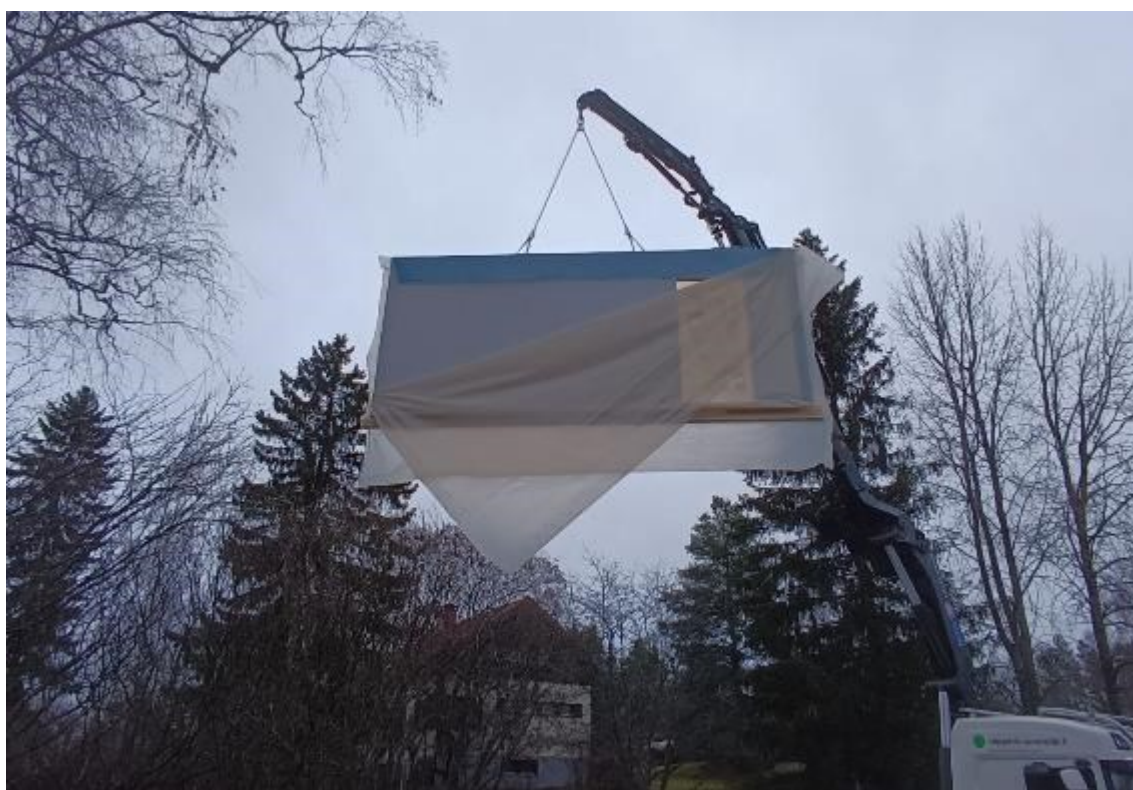
Kuva 5. Elementtien nostaminen
