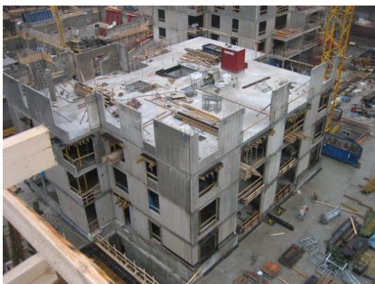
Kuva 19 Kantava holvirakenne (Pentti Lumme, 2016)
