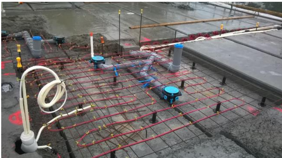
Kuva 13 Vieser vaakakaivoa käytetty kylpyhuonelaatassa (Marianne Lindberg, 2018)
