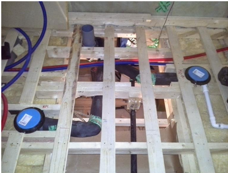
Kuva 14 Vieser vaakakaivoa käytetty puurakenteisessa välipohjassa (Vieser, 2018)
