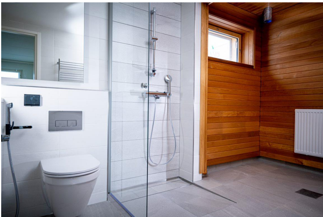
Kuva 1 Rakennusliike Hausia käyttänyt Vieser Line linjalattiakaivoa asuntorakentamisessa (Vieser, 2022)
