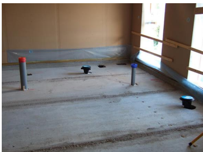
Kuva 17 Vieser pystykaivoa käytetty ontelolaattavälipohjassa (Vieser, 2020)
