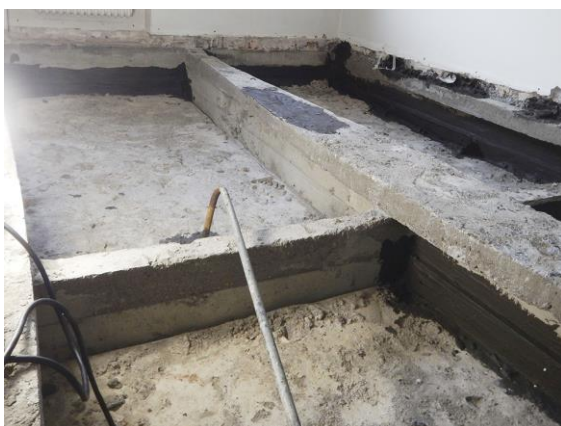
Kuva 18 Alalaattapalkistossa varsinainen lattiarakenne on toteutettu palkkien päälle teräsbetonista (Marit Sivén, 2022)
