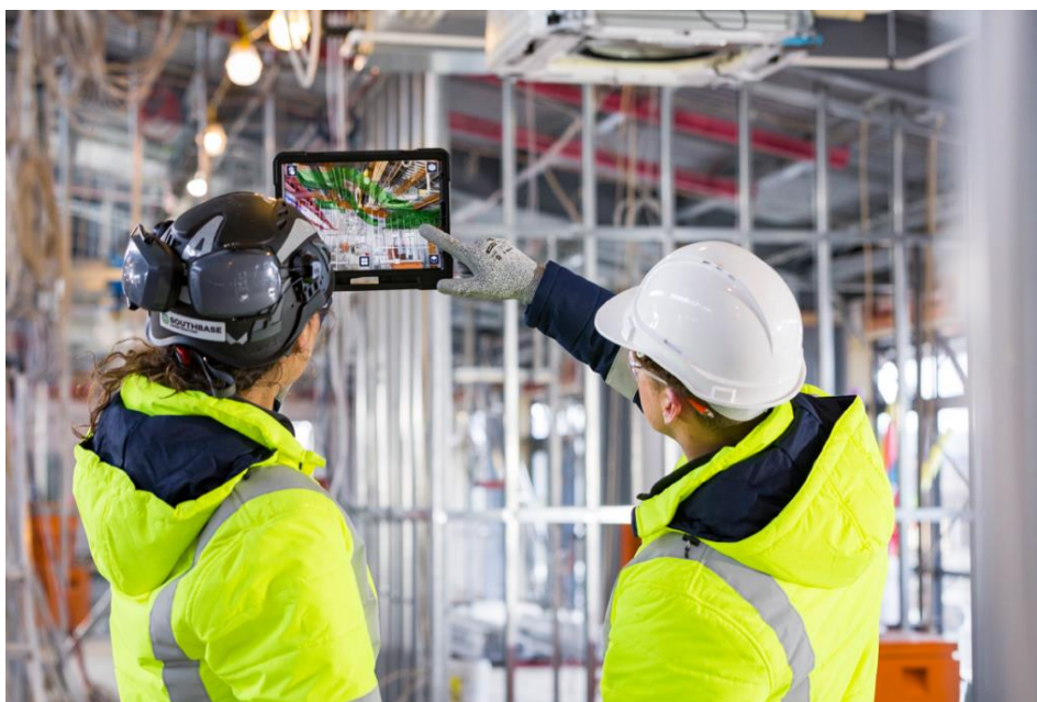
KUVA 19. Trimble Connectin AR -laajennussovelluksen käyttö (building point Finland)
