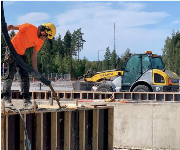
Kuva 4. Valumuottiin letkujen avulla. Helsingin Tahvonlahden alakoulu.
