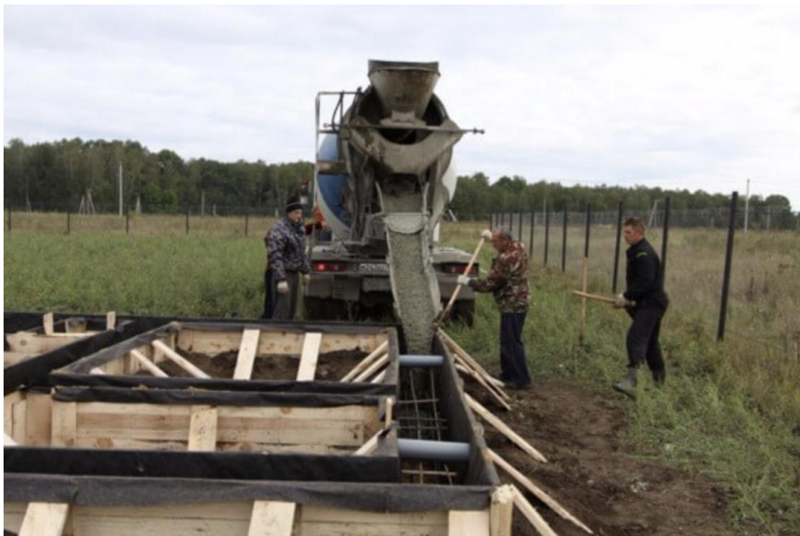
Kuva 3. Betonin valu sekoittimesta
