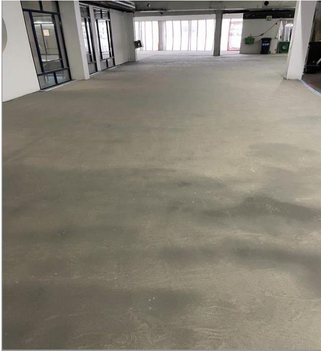
Kuva 7. Pumpputasoitus, valmis pinta.
