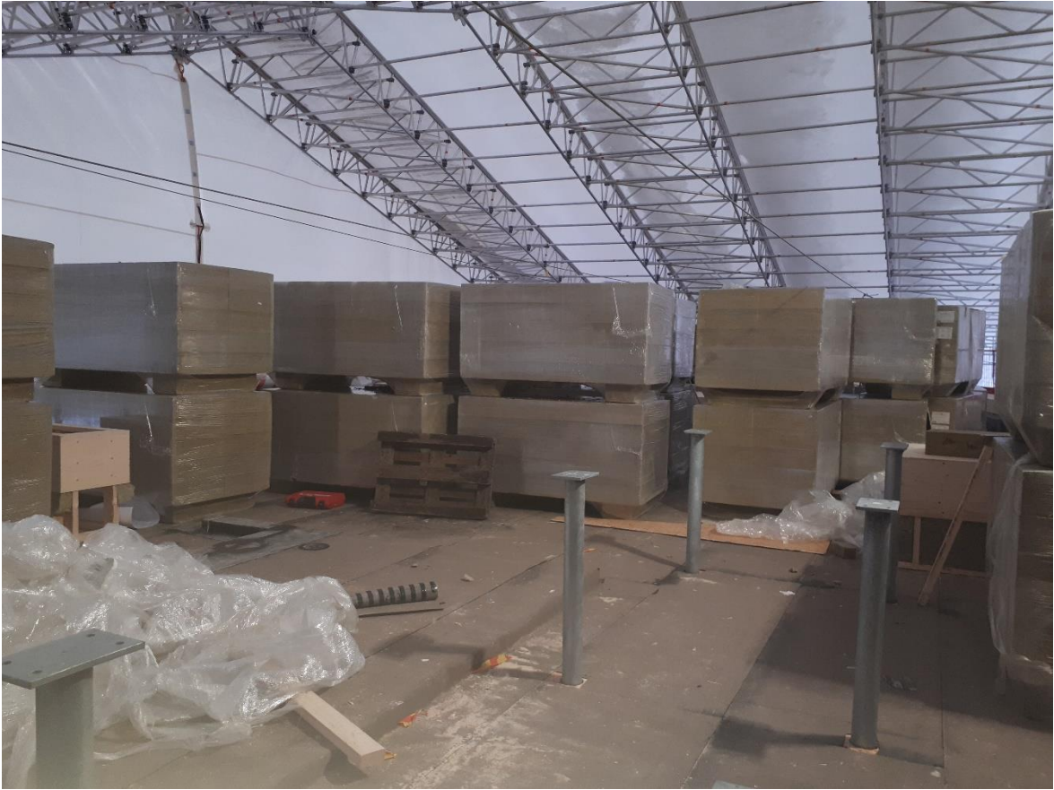
Kuva 4. Tyypillinen näkymä vesikattotyömaasta sääsuojassa. (Katto Yritys, dokumentit)
