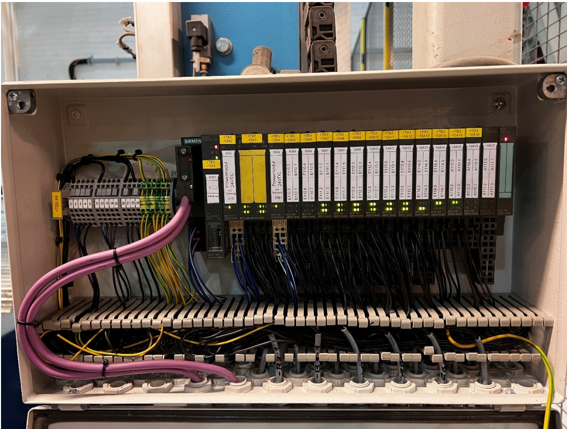
Kuvio 7. +TB3 position I/O-moduuli, johon on liitetty Siemensin 6ES7134-4GB11-0AB0 analogiatulokortti
