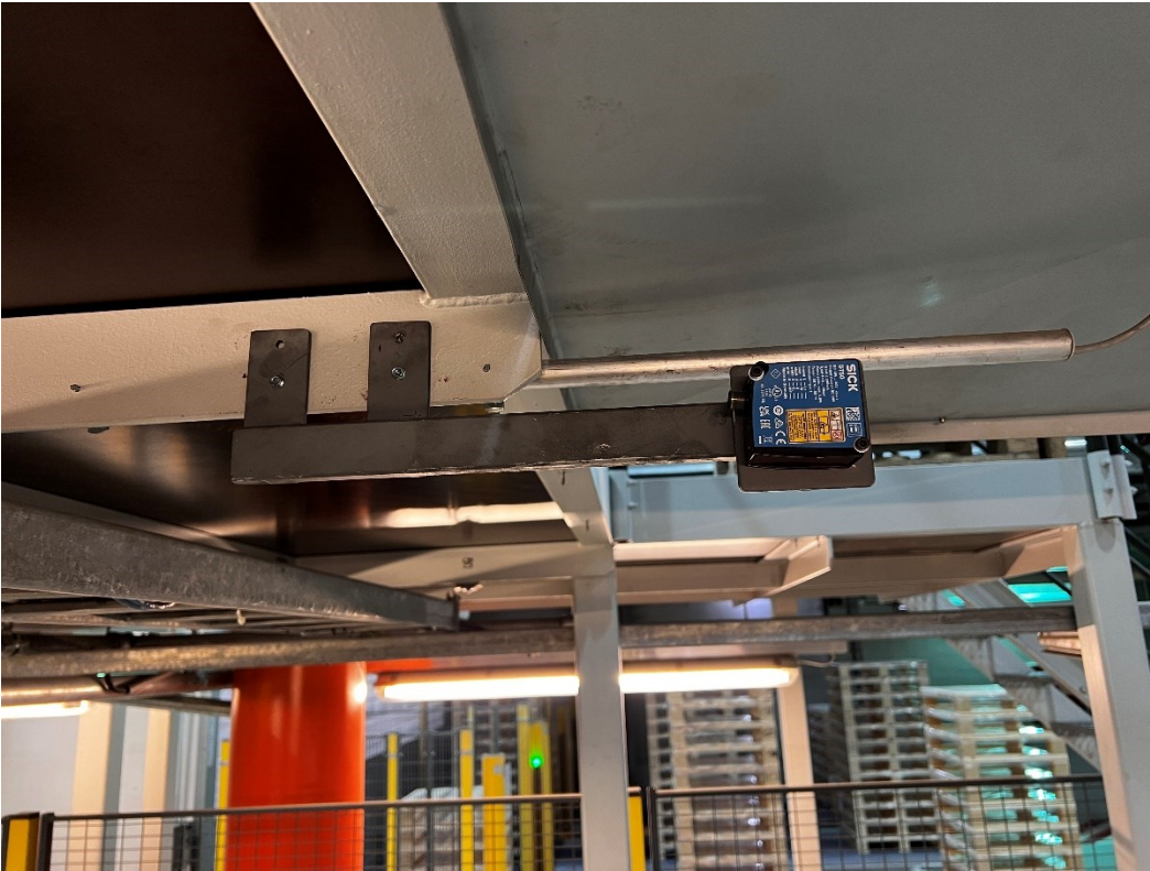
Kuvio 9. Anturin kiinnityspiste sekä teline
