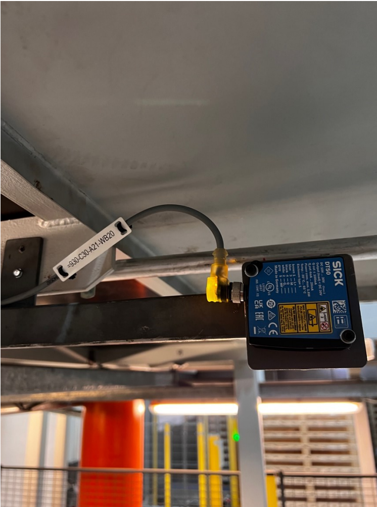
Kuvio 26. Asennuskohteen kaapelikilvet kiinnitettyinä
