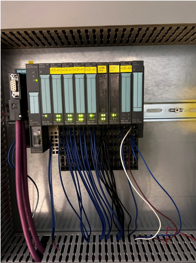
Kuvio 10. Analogiatulokorttiin kytketty anturikaapeli position +C30-A1 I/O-moduulissa
