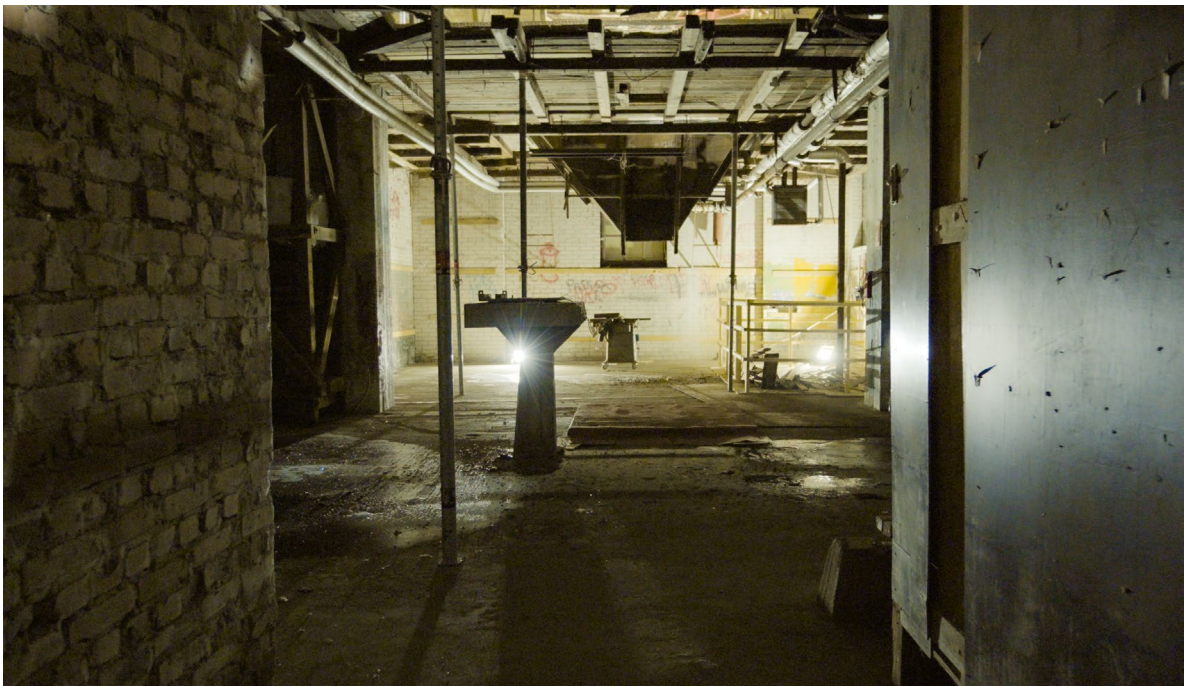
KUVA 30. Siilorakennuksen sisättilä ennen kunnostusta (Niemelä 2022)
