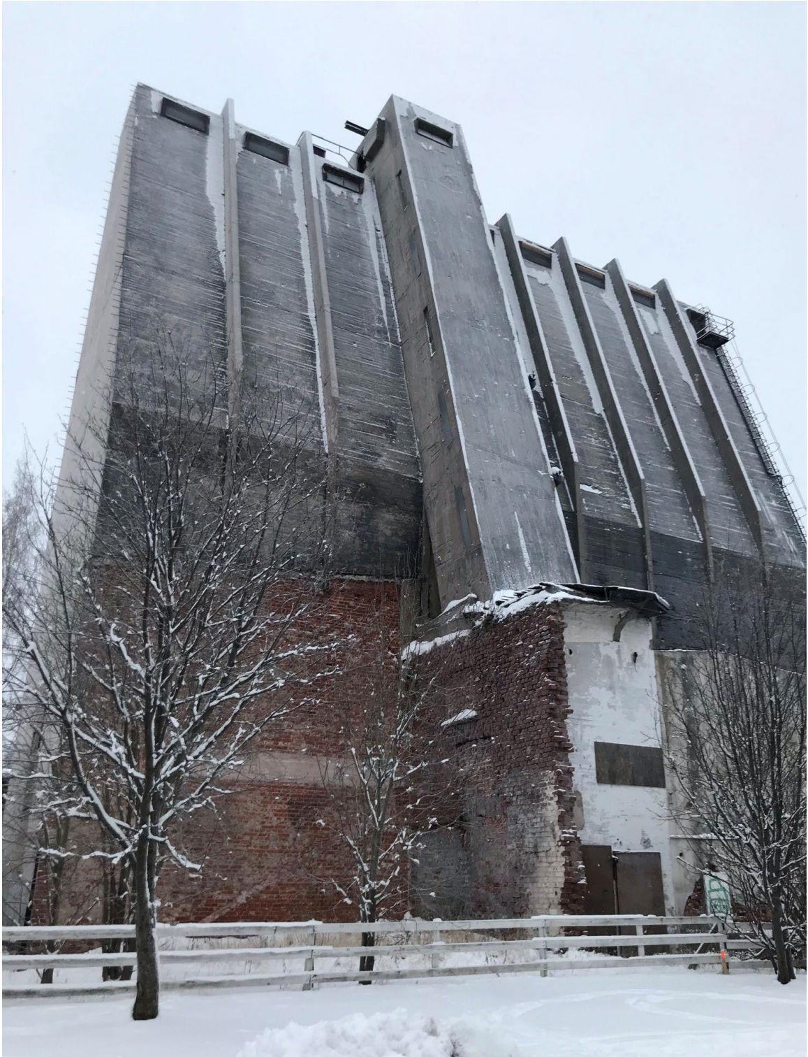
KUVA 15. Katedraalimainen siilorakennus muistuttaa muotokieleltään sakraalirakennusta
