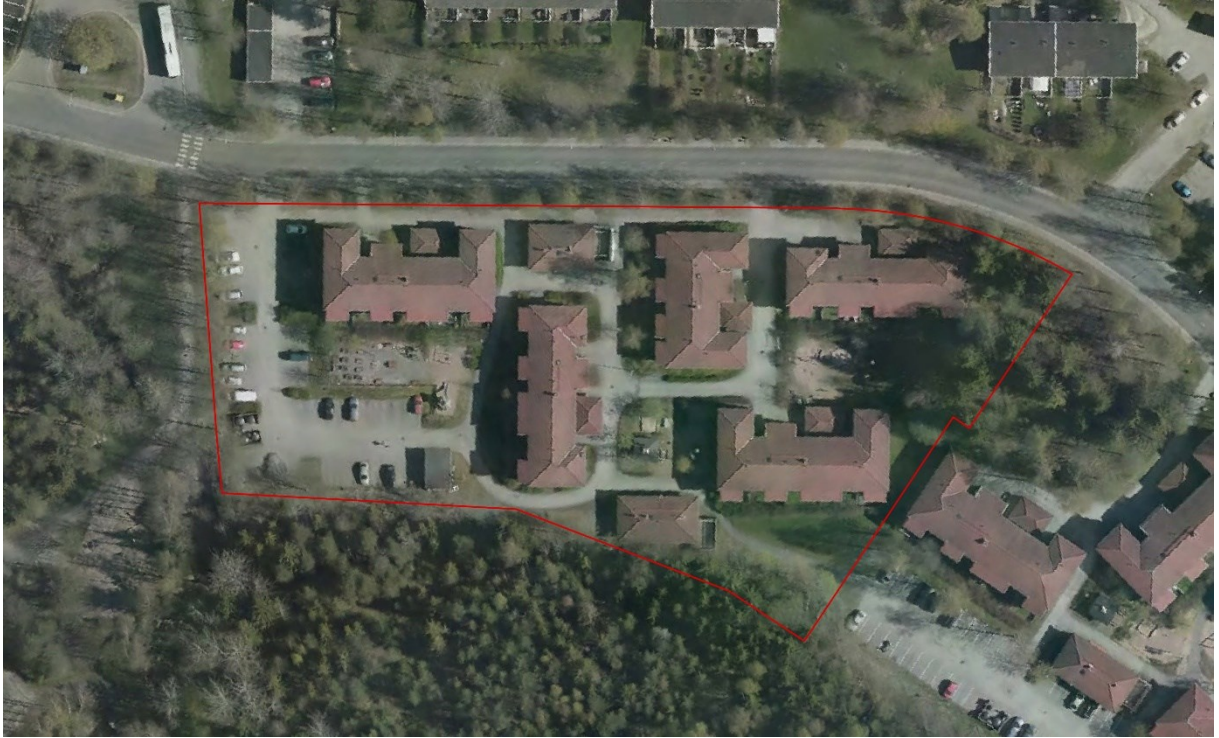
Kuva 3. Nikinväylä 10 ilmakuva. (Google Maps, 2022b)
