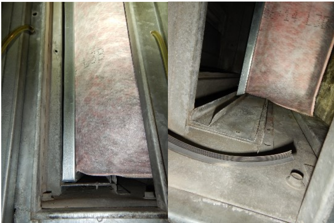
Kuva 7. Suodattimet ja suodatinkehikko
