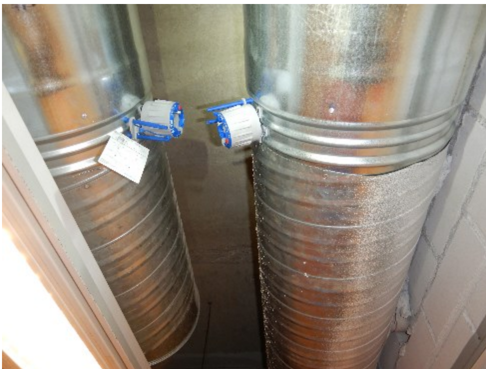
Kuva 18. Säätopeltejä
