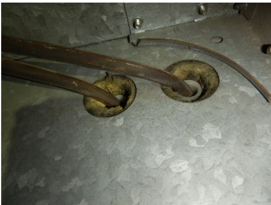
Kuva 11. Kaapeliläpiviennit puhallinkammiossa
