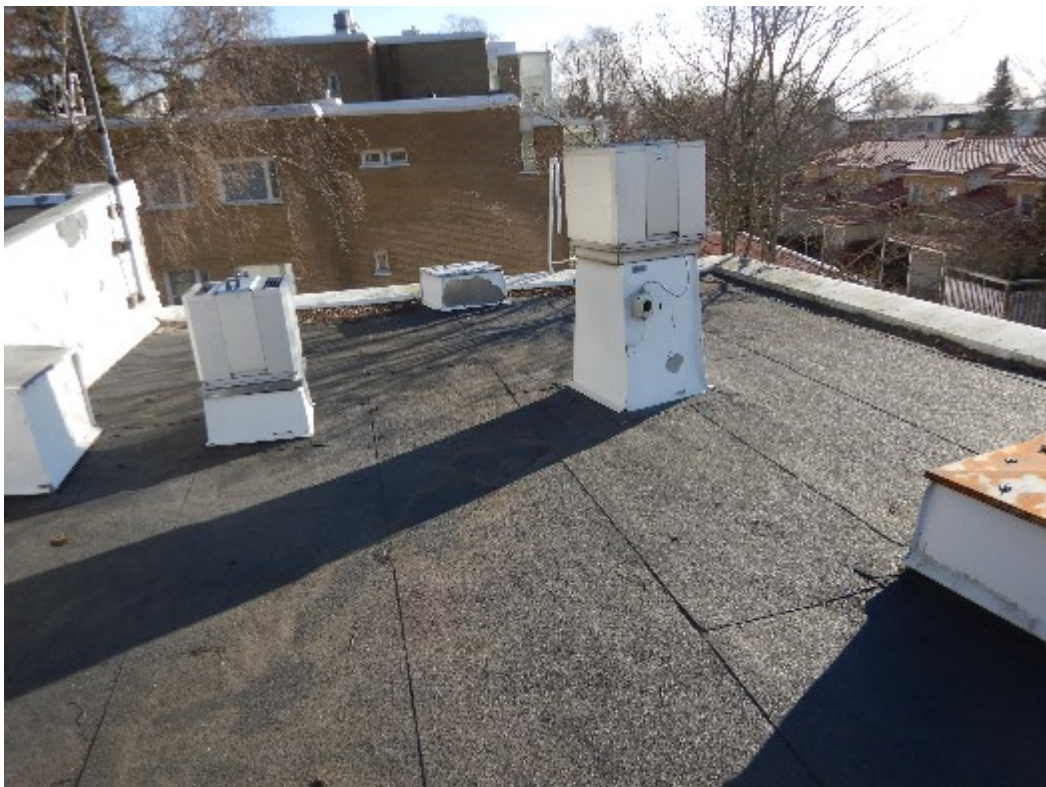
Kuva 14. Vesikaton huippuimureita
