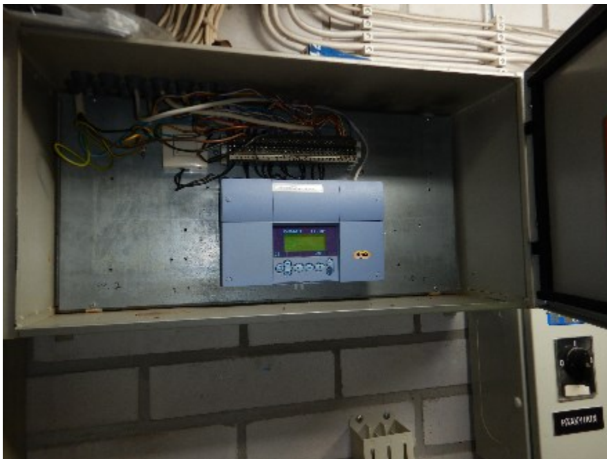
Kuva 24. Säätokekus
