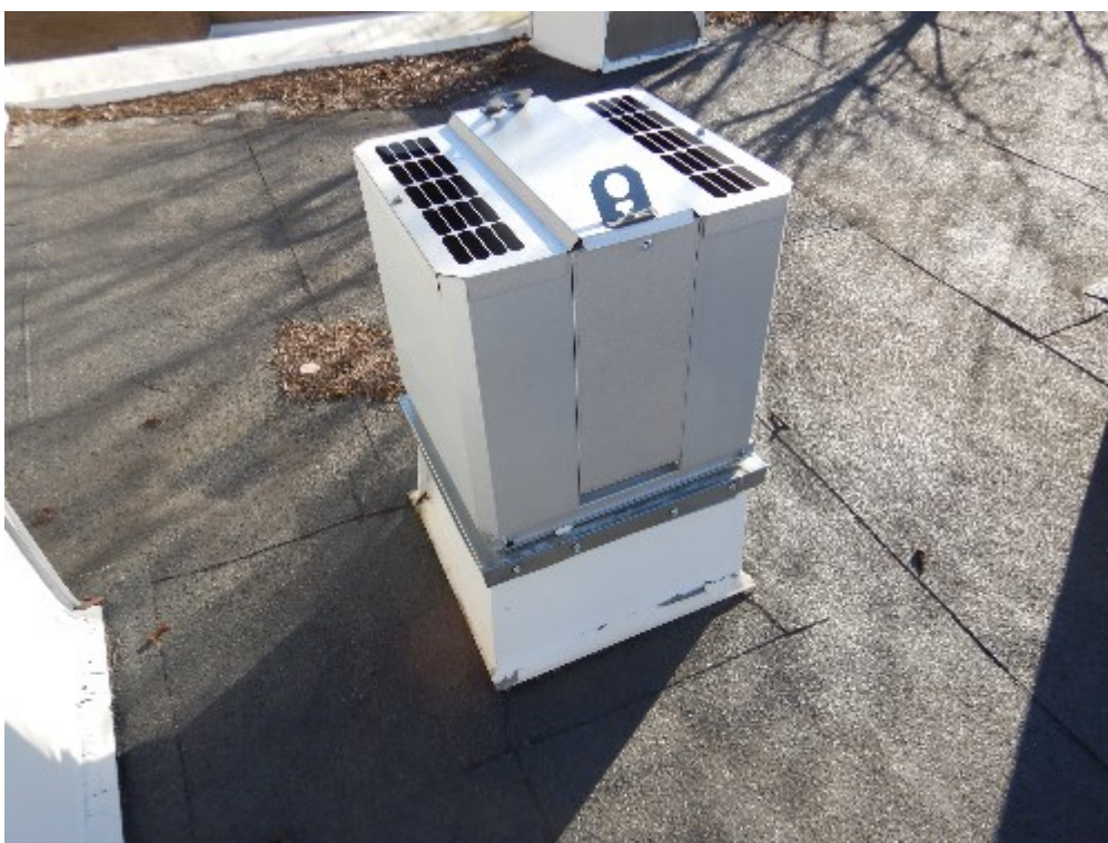
Kuva 15. Vesikaton huippuimuri
