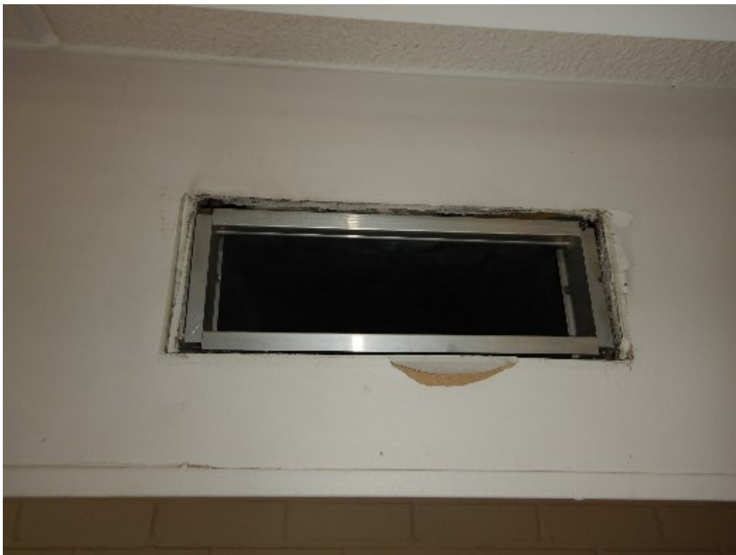
Kuva 21. Tuloilmaventtiili ilman säleikköä
