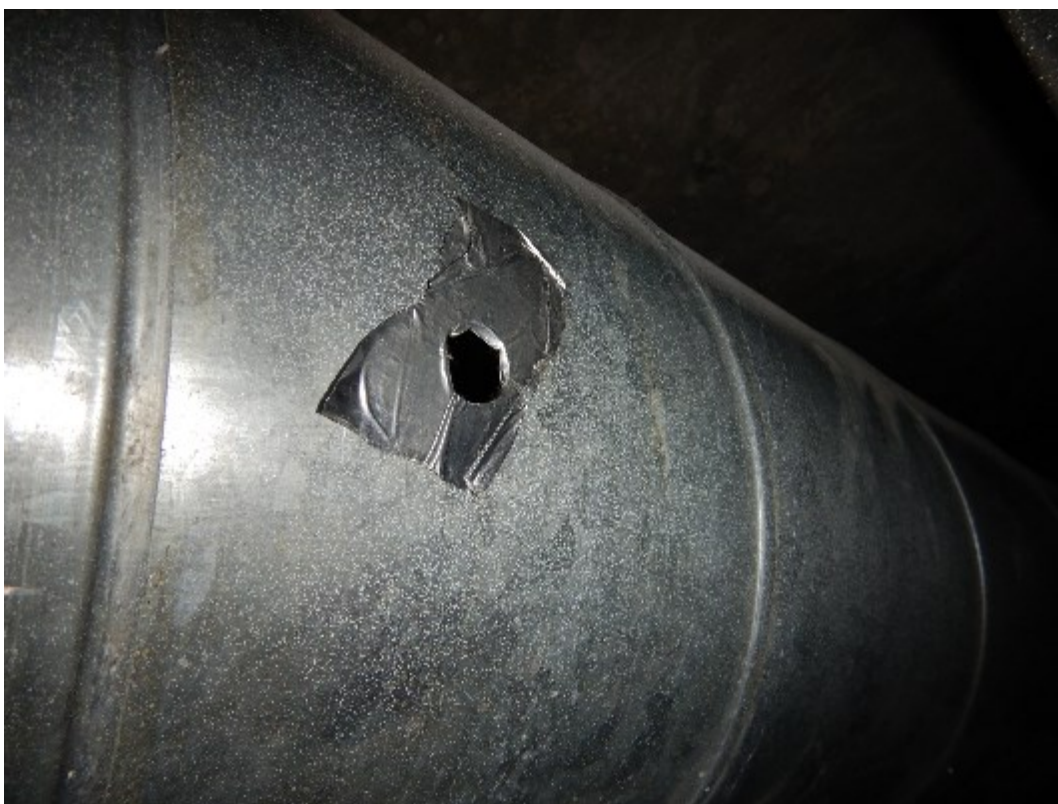
Kuva 17. Tulppaamaton mittareikä
