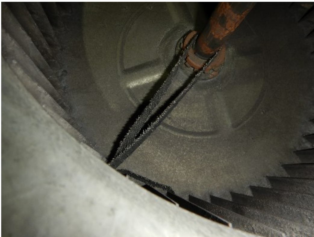
Kuva 10. Vanha higna puhaltimen akselissa
