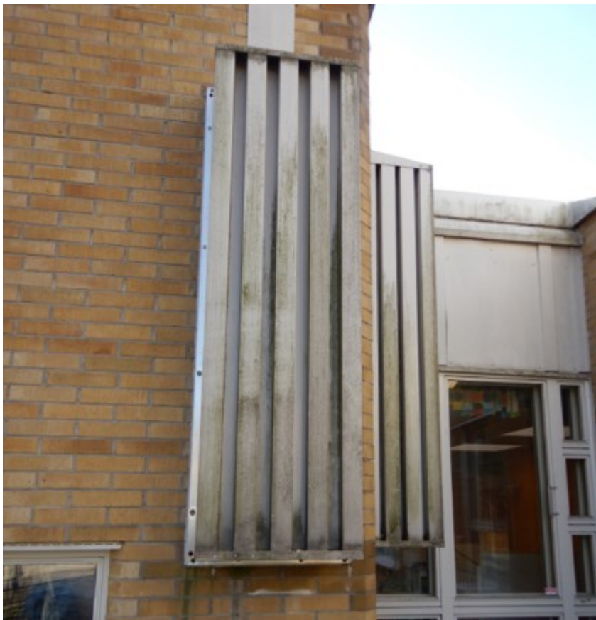
Kuva 3. Raitisilmasäleikkö
