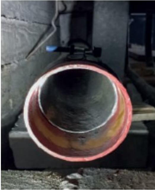
Kuva 2. Puhdistettu ja kuivattu viemäri [15]
