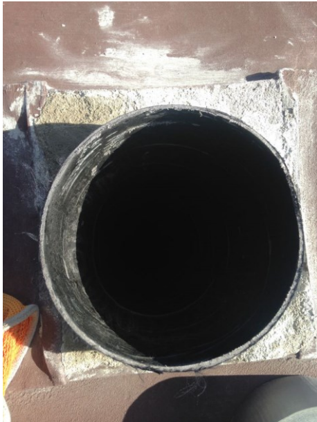
Kuva 5. Tiivistetty hormin sukka vesikatolla [13]
