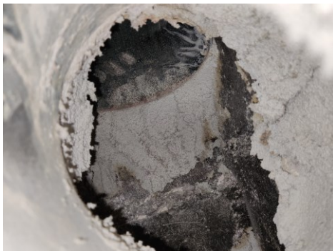
Kuva 6. Huoneiston päässä tiivistetty sukka [16]
