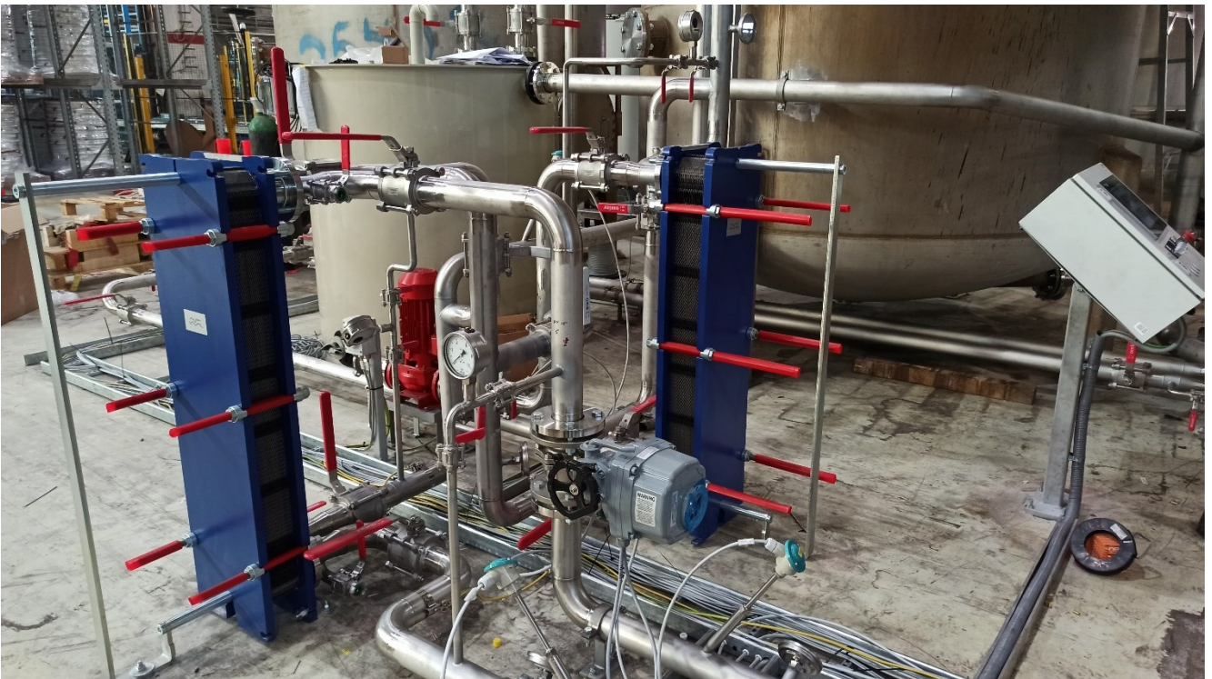
Kuva 17. Kuva asennusvaiheesta (Alapiha, 2022).
